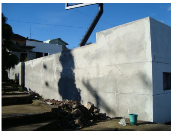
Figura 16: fachada ensaiada edificação B
