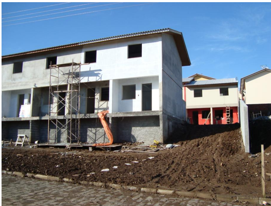
Figura 14: fachada norte da edificação A
