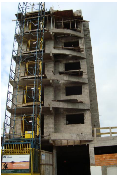
Figura 20: fachada sudoeste da edificação D
