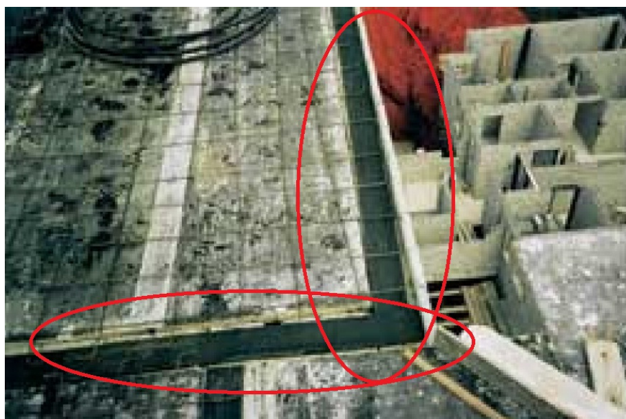
Figura 8 – forma de laje com neoprene colocado sobre a alvenaria (LOTURCO, 2005, p. 33)
