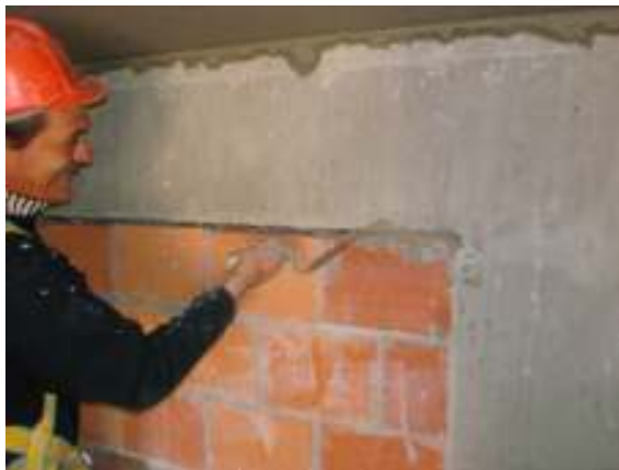
Figura 28: execução do encunhamento de paredes com argamassa
