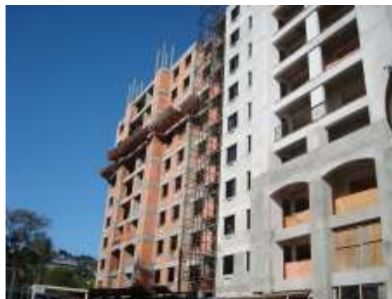
Figura 27: transporte vertical (guincho)
