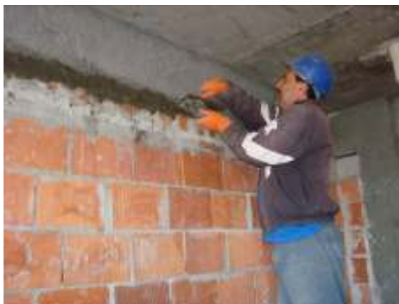
Figura 32: execução do encunhamento com auxílio de uma desempenadeira
