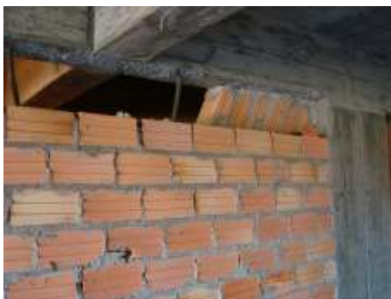
Figura 33: encunhamento rígido de paredes com tijolos inclinados a 45° no estacionamento
