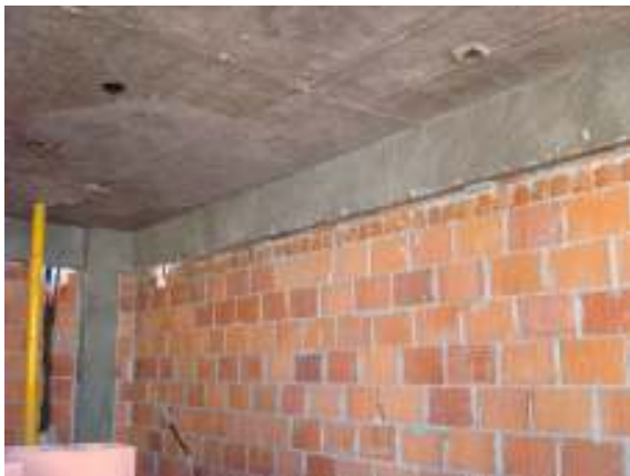
Figura 16: viga de comprimento aproximado de 10 m
