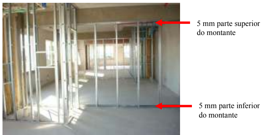
Figura 22: fixação de montantes para drywall na estrutura de concreto armado
