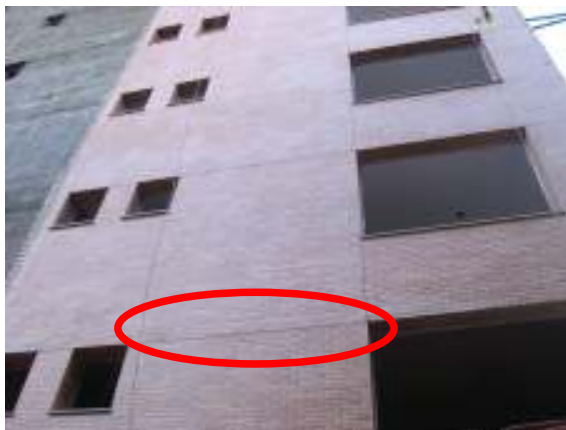
Figura 36: execução de juntas de movimentação na região de encunhamento de paredes
