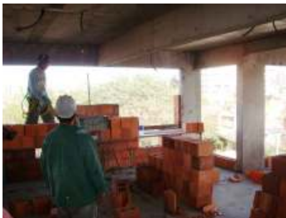
Figura 19: exemplo de execução da alvenaria no perímetro da edificação
