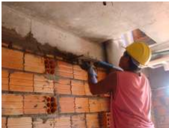
Figura 11: encunhamento com argamassa expansiva
