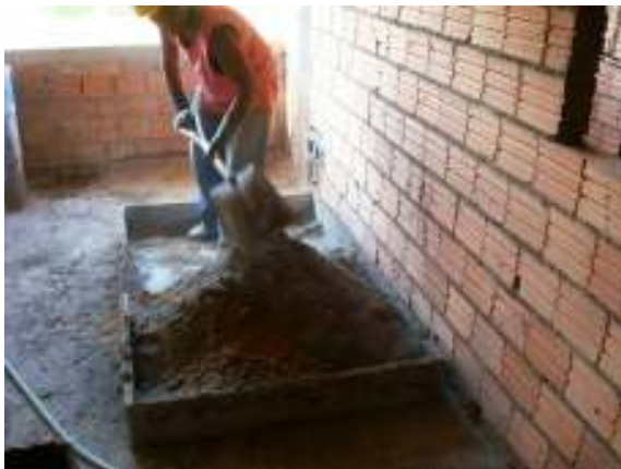
Figura 24: produção manual de argamassa de encunhamento
