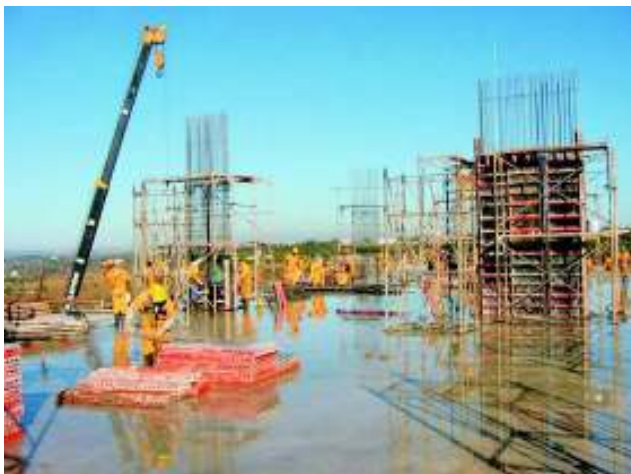
Figura 5: exemplo de processo de cura cuidadosa do concreto
