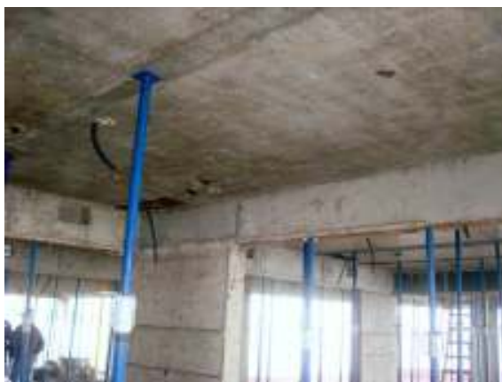
Figura 18: retirada de faixa de reescoramento em baixas idades
