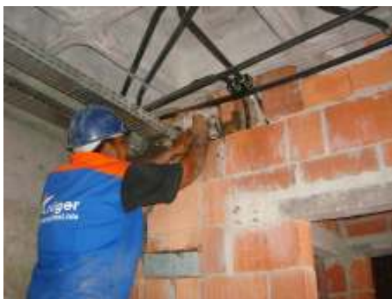
Figura 30: execução do encunhamento de paredes em sistemas de laje nervurada
