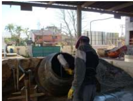
Figura 25: produção de argamassa de encunhamento mecanizada
