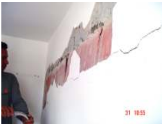
Figura 46: esmagamento de bloco (doada por construtora)
