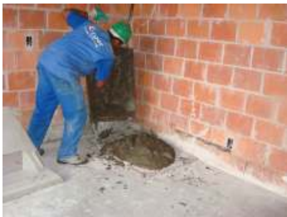
Figura 26: despejo da argamassa de encunhamento em cima de compensado
