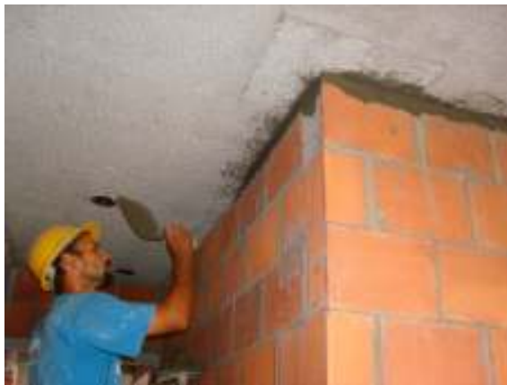
Figura 29: execução do encunhamento de paredes com aplicação de argamassa em grande distância
