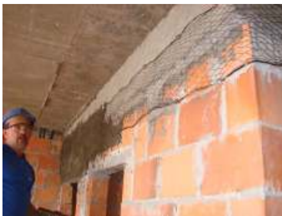
Figura 35: colocação de tela metálica na ligação estrutura com alvenaria
