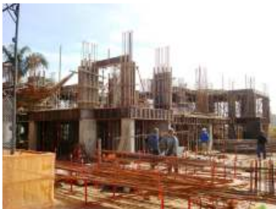
Figura 15: execução da estrutura de concreto armado da edificação
