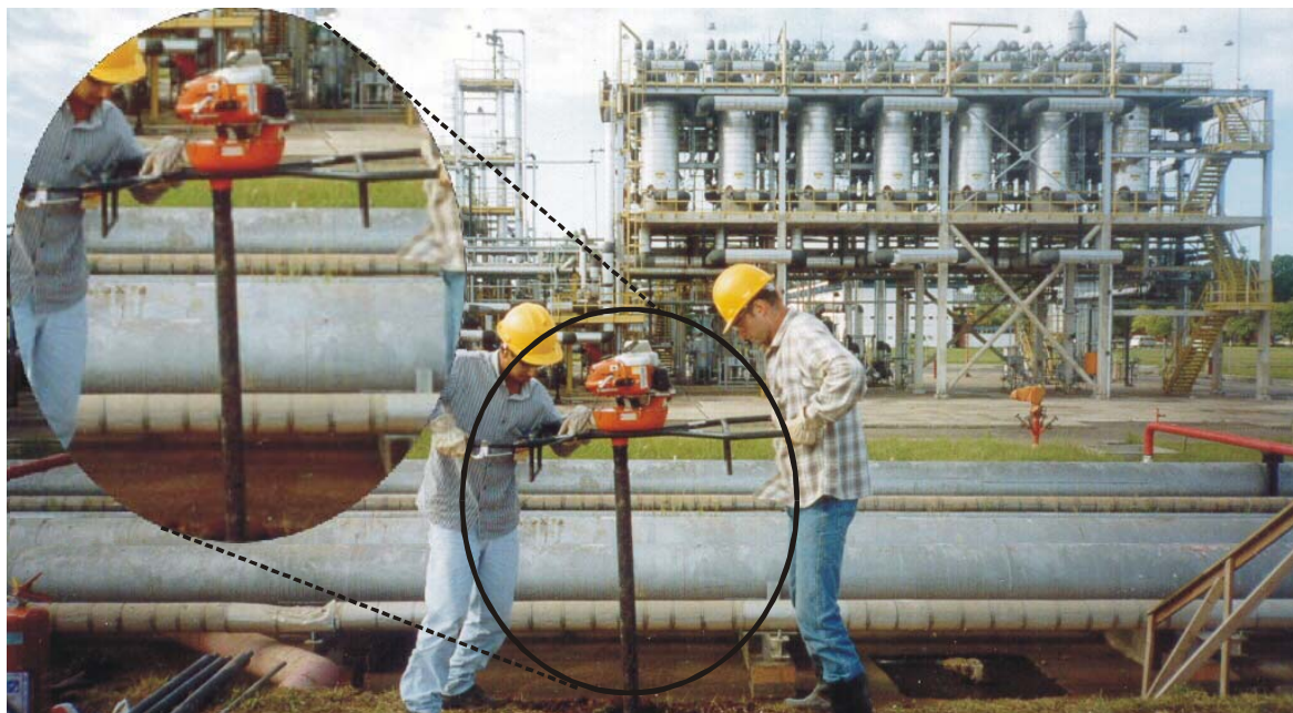
Foto 3.1: Perfuração com trado mecânico.
