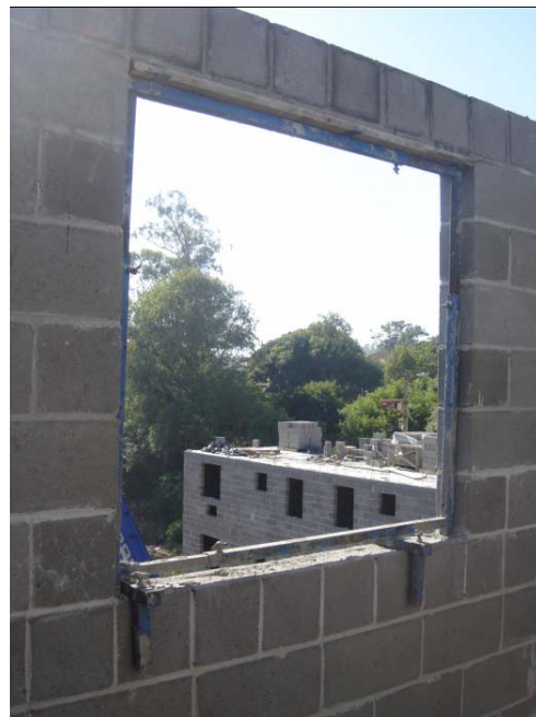
Figura 28: contraverga e cinta de amarração feitas com blocos meia canaleta
