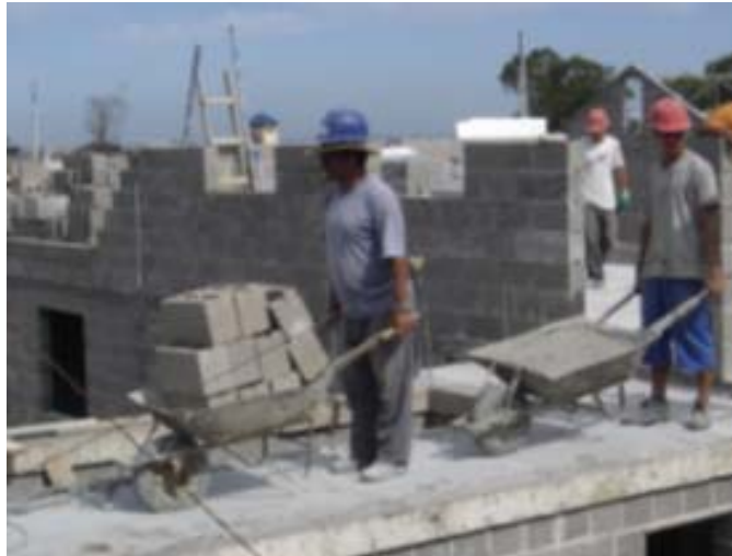
Figura 23: transporte horizontal de blocos e argamassa
