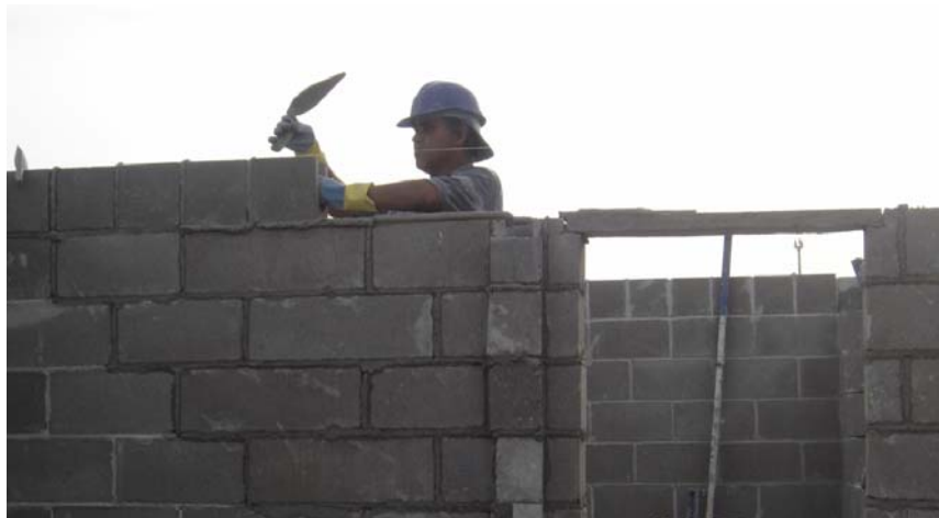
Figura 19: assentamento de blocos meia canaleta na última fiada
