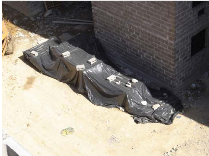
Figura 25: estoque de blocos cobertos com lona plástica e sobre palets
