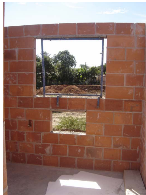
Figura 39: contravergas e cinta de amarração com bloco canaleta
