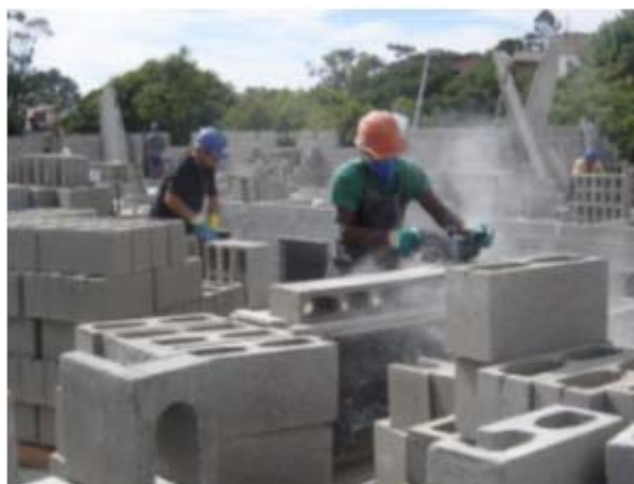
Figura 26: blocos sendo serrados no pavimento
