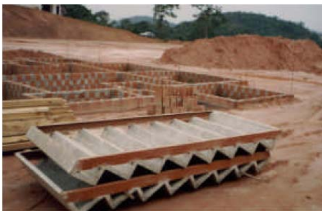
Figura 5: escada pré-moldada (RAMOS, 2001, p. 18)
