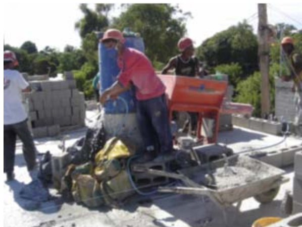
Figura 20: produção de argamassa no pavimento
