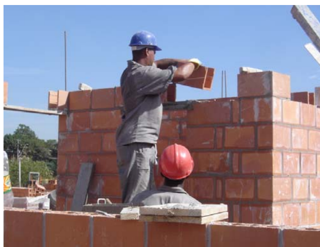
Figura 33: assentamento de bloco canaleta na última fiada
