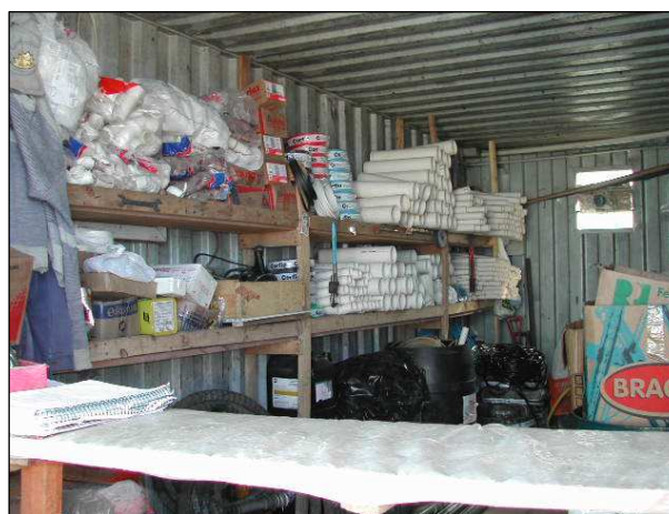
Figura 8: almojarifado desorganizado, com materiais sem etiqueta para controle. Fonte: COSTA, et al., 2003.
