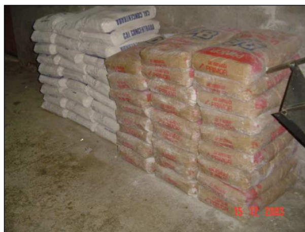
Figura 17: exemplo de bom armazenamento de cimento. Fonte: COSTA, et al. 2003.
