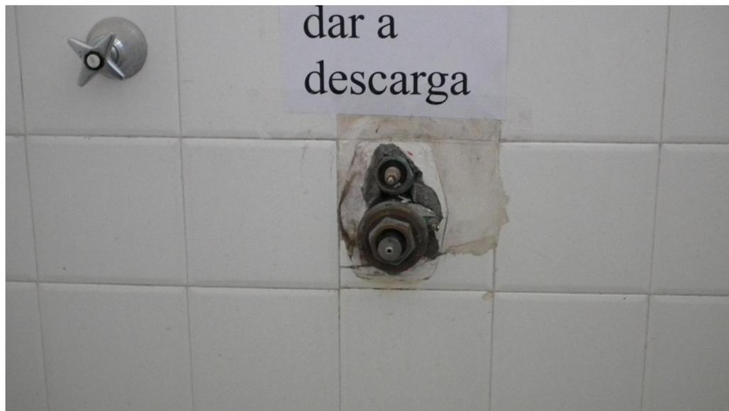
Figura 7: válvula de descarga sem acabamento
