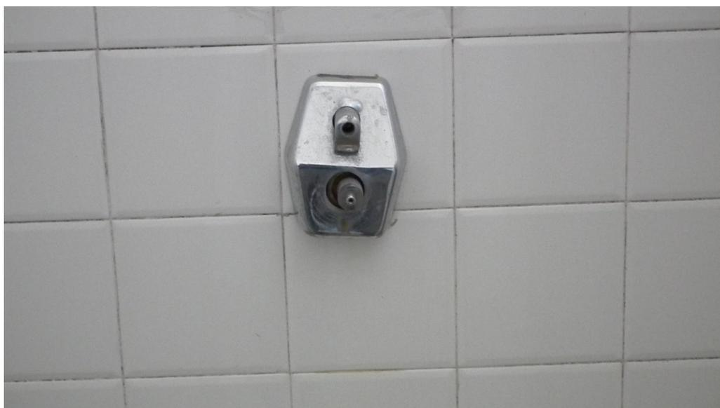
Figura 6: válvula de descarga sem parte do acabamento
