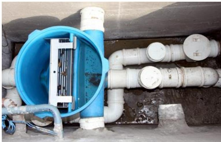
Figura 17: reservatório com filtro acoplado (BRASIL, 2004)
