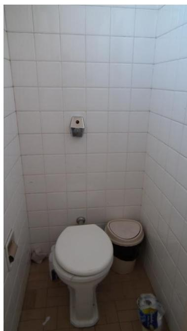
Figura10: válvula de descarga sem controle de vazão
