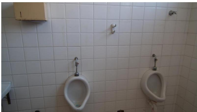
Figura 9: válvula de mictório sem fechamento automático
