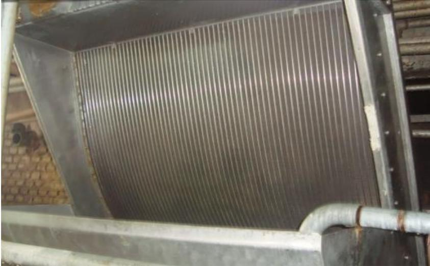
**Figura 10:** Foto do filtro utilizado para remoção de sólidos e matéria orgânica da água de lavagem de gaiolas.
