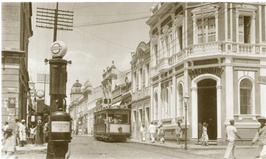
Figura 1 – Banco do Brasil no início da década 1930 na cidade de Fortaleza.
