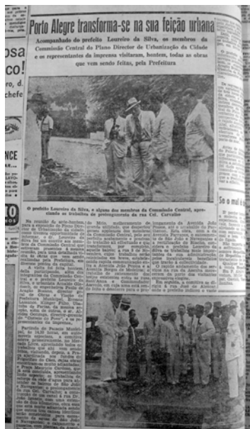
FIGURA 37 – Visita às obras. Fonte: Correio do Povo , Porto Alegre, p. 12. 5 março 1939.
