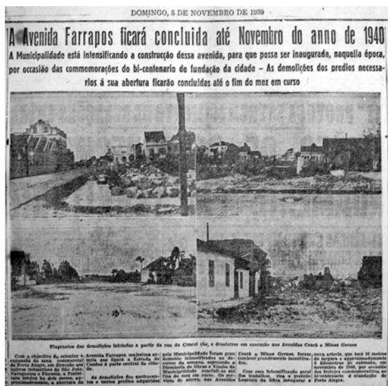
FIGURA 38 – Obras avenida Farrapos.
