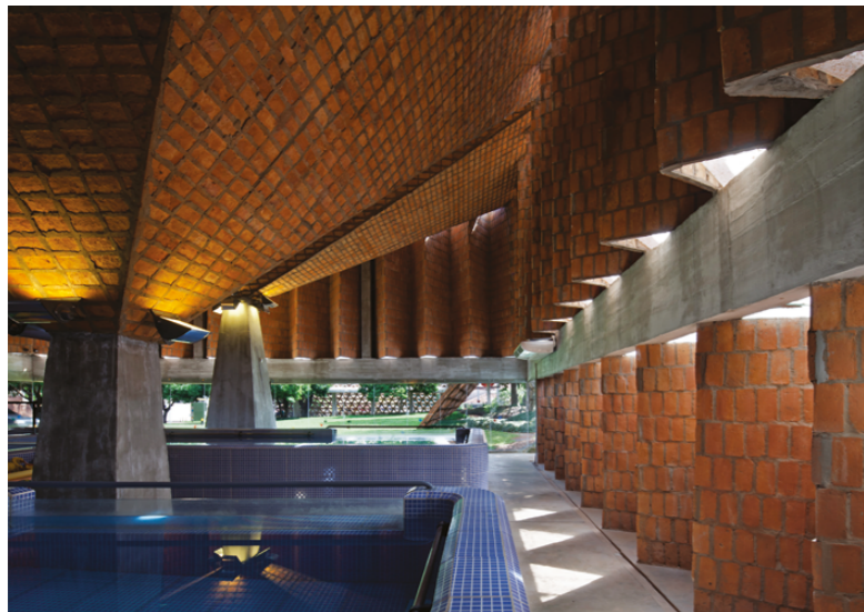
Figura 5. Interior del bloque de hidroterapia de la Fundación Teletón Paraguay (2008-10). Fuente: Leonardo Finotti ( www.leonardofinotti.com/projects/teleton ).
