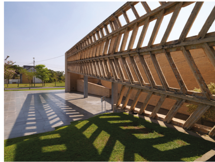
Figura 6. Celosía en la fachada de Unilever Paraguay (2000-01). Fuente: Enrico Cano ( www.enricocano.com/solano-benitez ). | Figura 7. Planta baja, sección longitudinal, fachadas y detalle de la celosía del edificio Unilever Paraguay (2000-01). Fuente: Dibujos de la autora.
