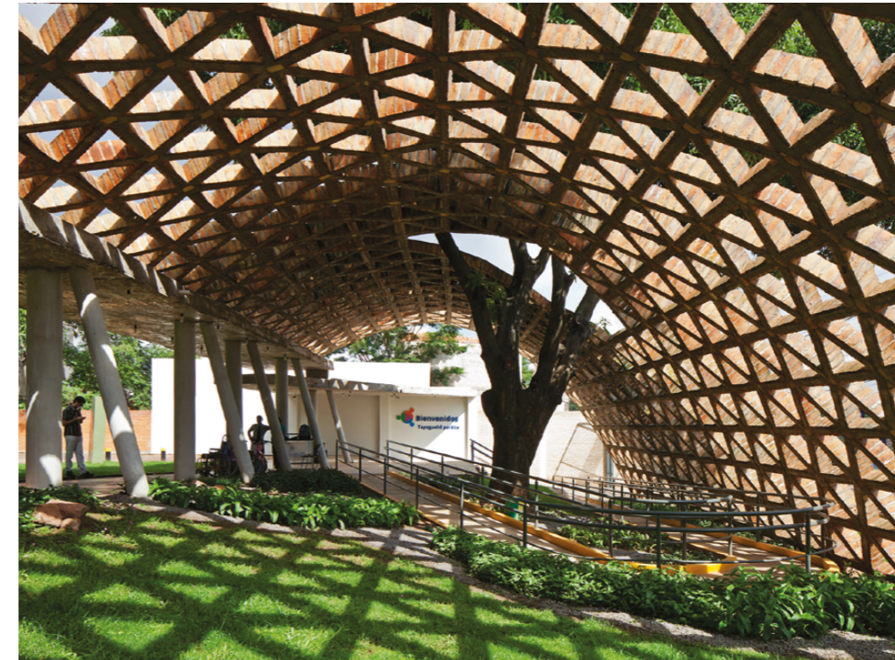
Figura 9. Cobertura con elementos triangulares sobre las rampas en la Fundación Teletón Paraguay (2008-10). Fuente: Leonardo Finotti ( www.leonardofinotti.com/projects/teleton ).
