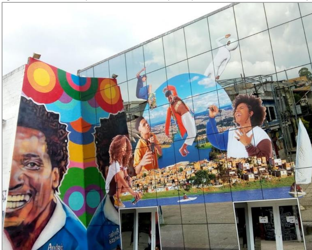
Figura 12: Facha espelhada e entrada principal do Centro Cultural Grajaú
