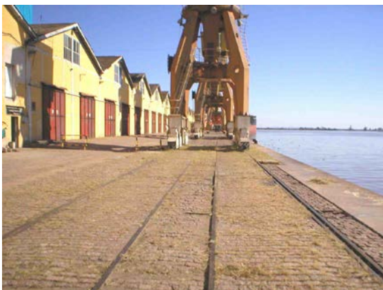
Figuras 67 e 68: À esquerda, vista da pavimentação e das linhas de trilhos entre os armazéns e a borda do cais. À direita, a pavimentação de blocos de concreto e a de paralelepípedos de granito.
