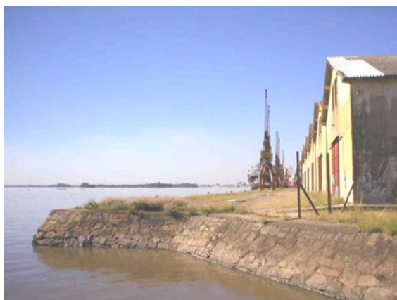
Figuras 75 e 76: À esquerda, vista da extremidade oeste do Cais Mauá, onde o aterro de gravidade é finalizado. À direita, vista do Armazém A7, o único não original no conjunto.
