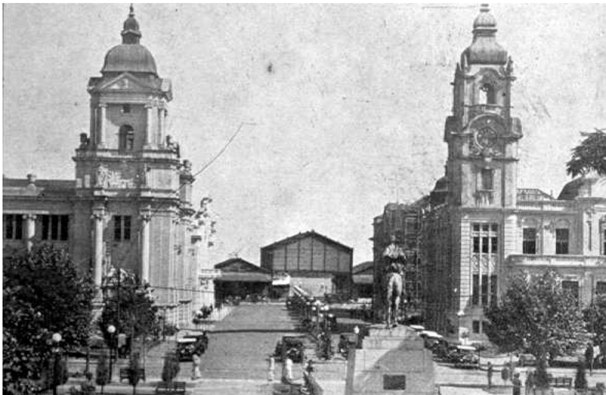
Figura 53: Foto da Praça da Alfândega nos primeiros anos após a construção dos edifícios do Correios e Telégrafos, à direita, e Delegacia Fiscal, à esquerda, que conformam o eixo monumental da Av. Sepúlveda. Em primeiro plano, a estátua eqüestre do General Osório.
