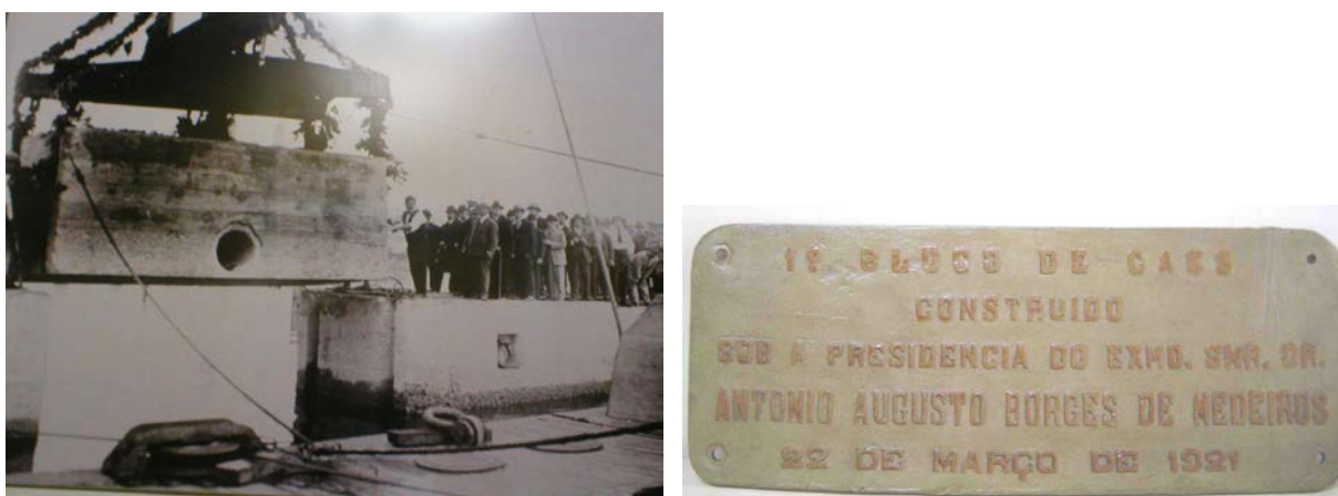
Figuras 9 e 10: Fotografias do primeiro bloco de concreto lançado às águas do Guaíba em 1921 e da placa comemorativa que estava afixada a esta peça.
