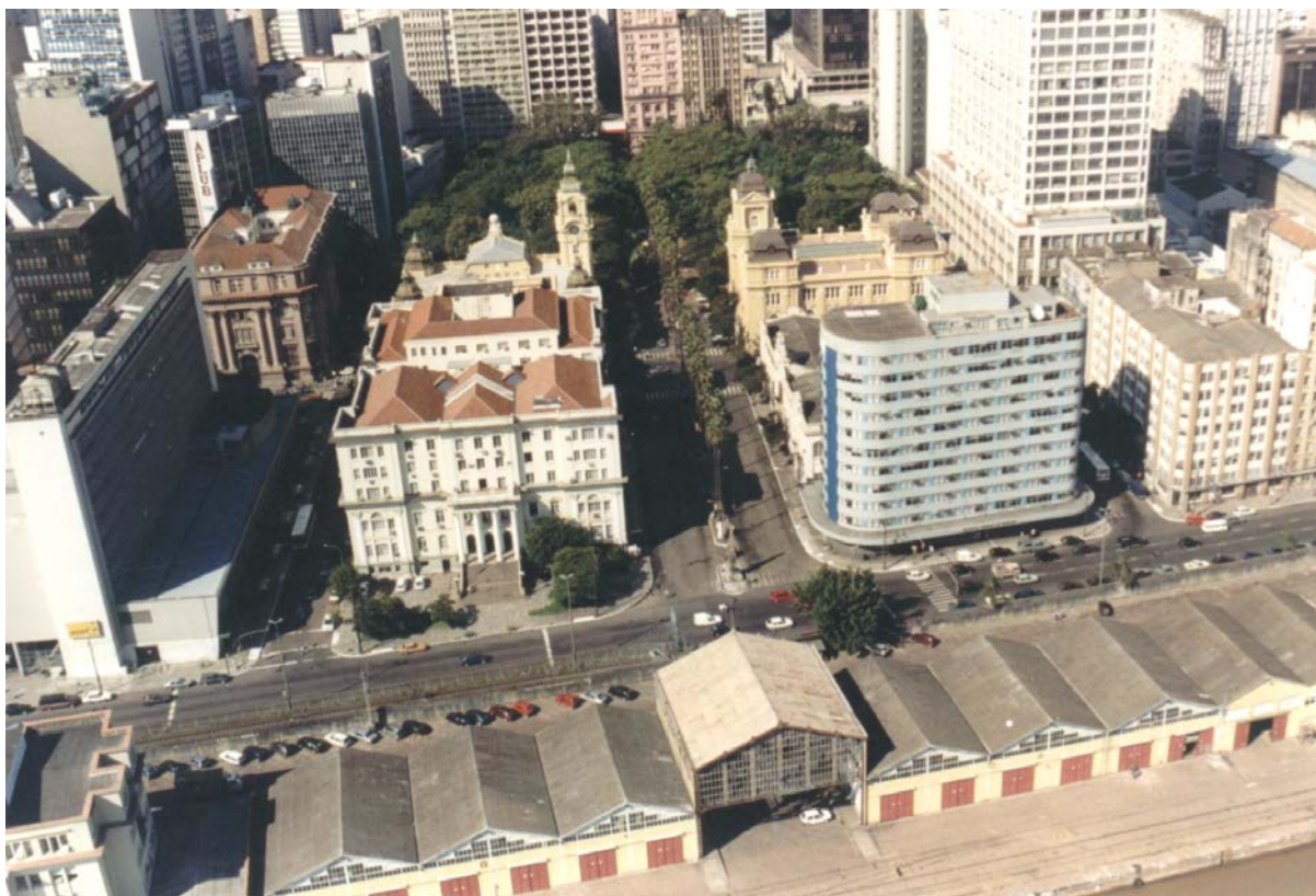
Figura 20: Fotografia aérea do Pórtico Central e Armazéns A e B do Cais Mauá. A Av. Sepúlveda é o eixo da composição que se finaliza na Praça da Alfândega.
