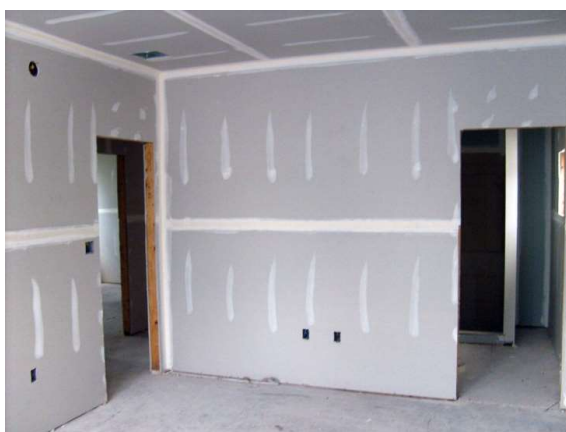
Figura 6: exemplo de Drywall
