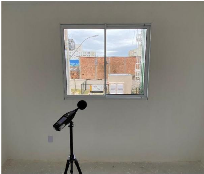
Figura 28 - Vista interna da fachada do dormitório avaliado
