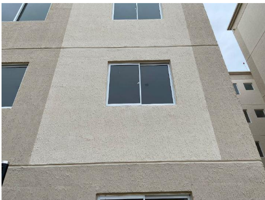
Figura 27 - Fachada onde foi realizado o ensaio
