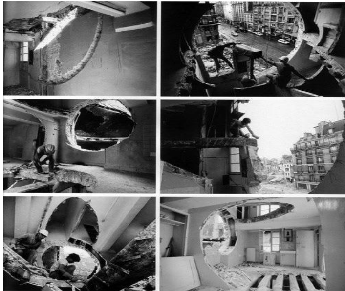
Interior dos cortes da construção/demolição de Conical Intersect Imagem: ( http://agentsofurbanism.com/2008/06/is-rem-koolhaas-channeling-gordon-matta-clark/ )
