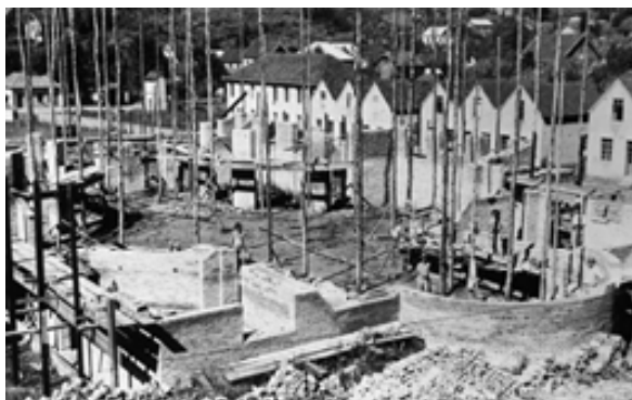
Imagem 75 - O início da obra da paróquia, com os seus alicerces sendo construídos ao centro do antigo Campo Central, e, ao fundo, parte do casario da antiga Vila Operária.
