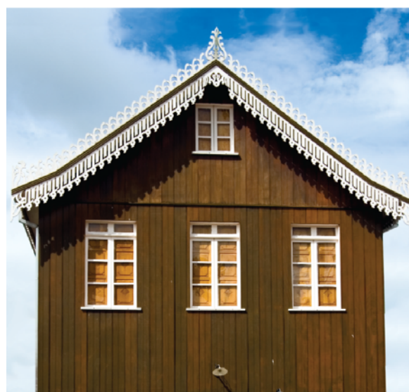
Imagem 49 – Lambrequins em madeira da Casa Laurindo Paim Sobrinho.
