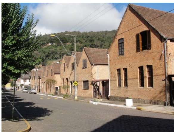
Imagem 82 - As casas de alvenaria de tijolos aparentes construídas para abrigar os operários do lanifício que formavam a antiga Vila operária, vistas da rua Pedro Chaves.
