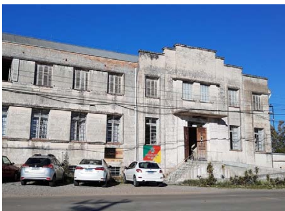
Imagem 107 – Prédio da Escola Familiar Agrícola da Serra Gaúcha (EFASSERRA), localizada na Terceira Léguas, na comunidade de São Pedro, no município de Caxias do Sul.
