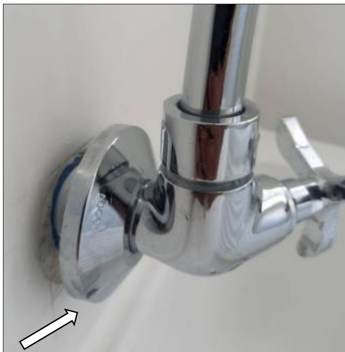
Figura 27 - Imagem de um metal com a canopla solta.
