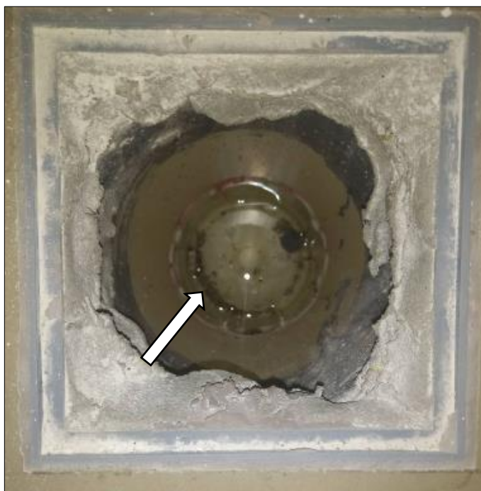
Figura 29 - Ralo entregue com fecho hídrico e sem sifão.
