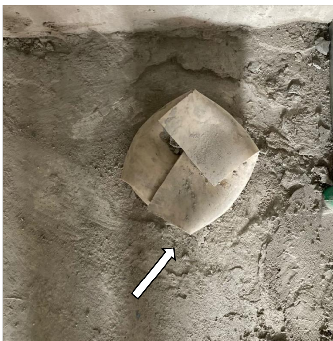
Figura 16 – Tamponamento da passagem do ralo. A seta indica o ralo tamponado.
