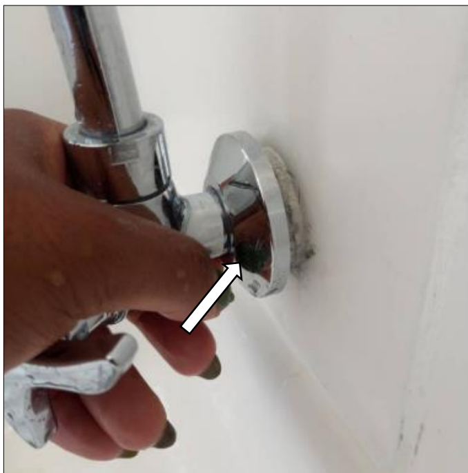
Figura 25 - Imagem de um metal com a canopla solta, como indicado pela seta.
