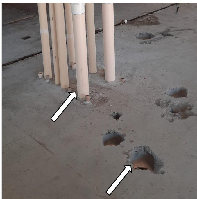
Figura 15 – Execução das fixações das passagens definitivas. As setas indicam passagens finalizadas e passagens que serão executadas.
