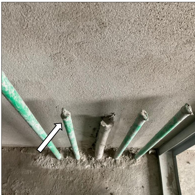
Figura 21 – Tamponamento das passagens hidráulicas para evitar entupimento.
