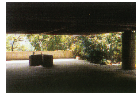
Figura 67: Vista primeiro pavimento térreo
