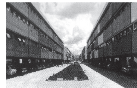
Figura 74: Vista da rua interna entre os blocos
