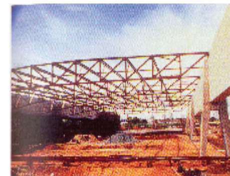
Figura 164/165: Vistas projeto em construção
