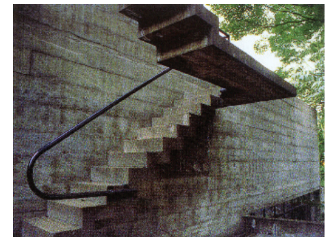
Figura 78-79: Vista do acesso Fonte: SPIRO, Annette. Paulo Mendes da Rocha . Verlag Niggli AG, Sulgen, Zurich. 2002, 271 p: il. p. 74-79
