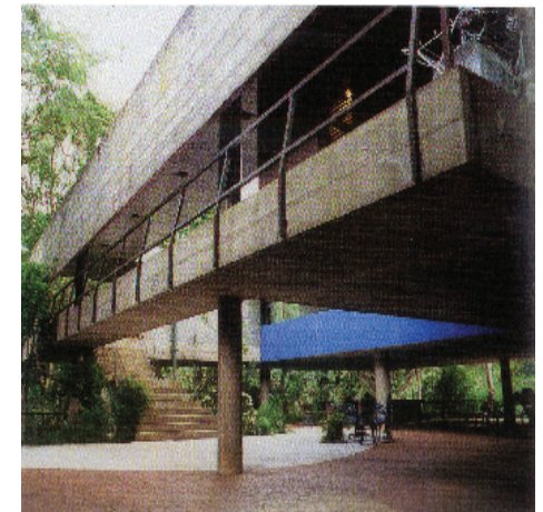
Figura 101-102: Vistas da lateral do pátio.
