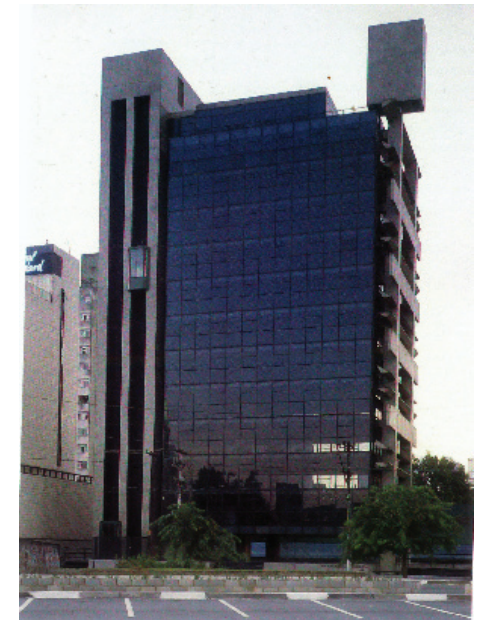
Figura 156: Vista da fachada
