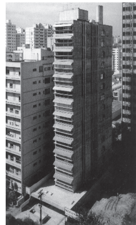
Figura 68: Vista geral do edifício
