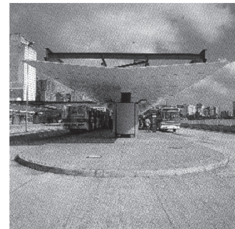
Figura 267-Vista da plataforma de embarque
