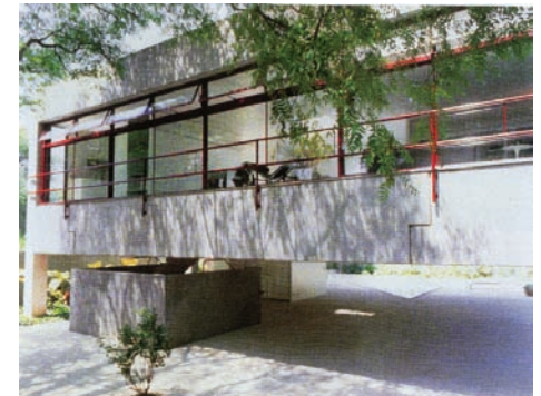
Figura 206/207: Vista da sala para pátio/Vista da entrada
