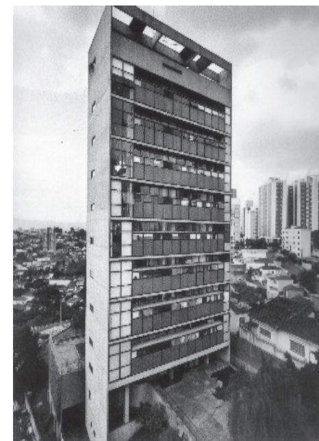
Figura 151: Vista da fachada sul Fonte: ARTIGAS, Rosa (ORG). Paulo Mendes da Rocha. 1957-1999. 3ed. São Paulo; Cosac Naify, 2006. 240pg., 342ils, pg152-157
