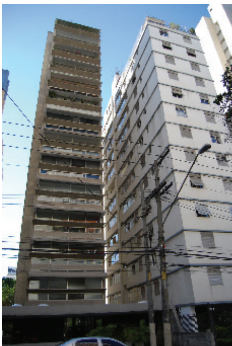
Figura 69-Fotografia autora edifício Guaimbé
