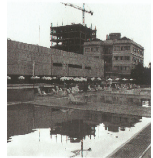
Figura 47: Vista externa com as piscinas e a fachada leste
