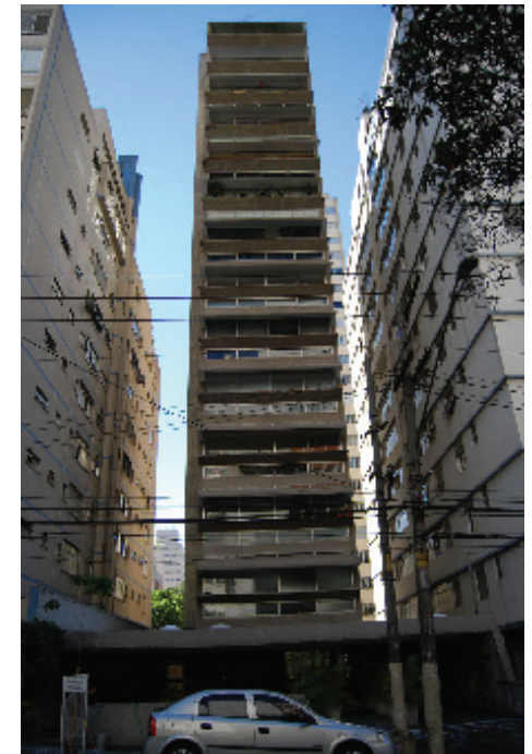
Figura 71 -Fotografia autora-Edifício Guaimbé
