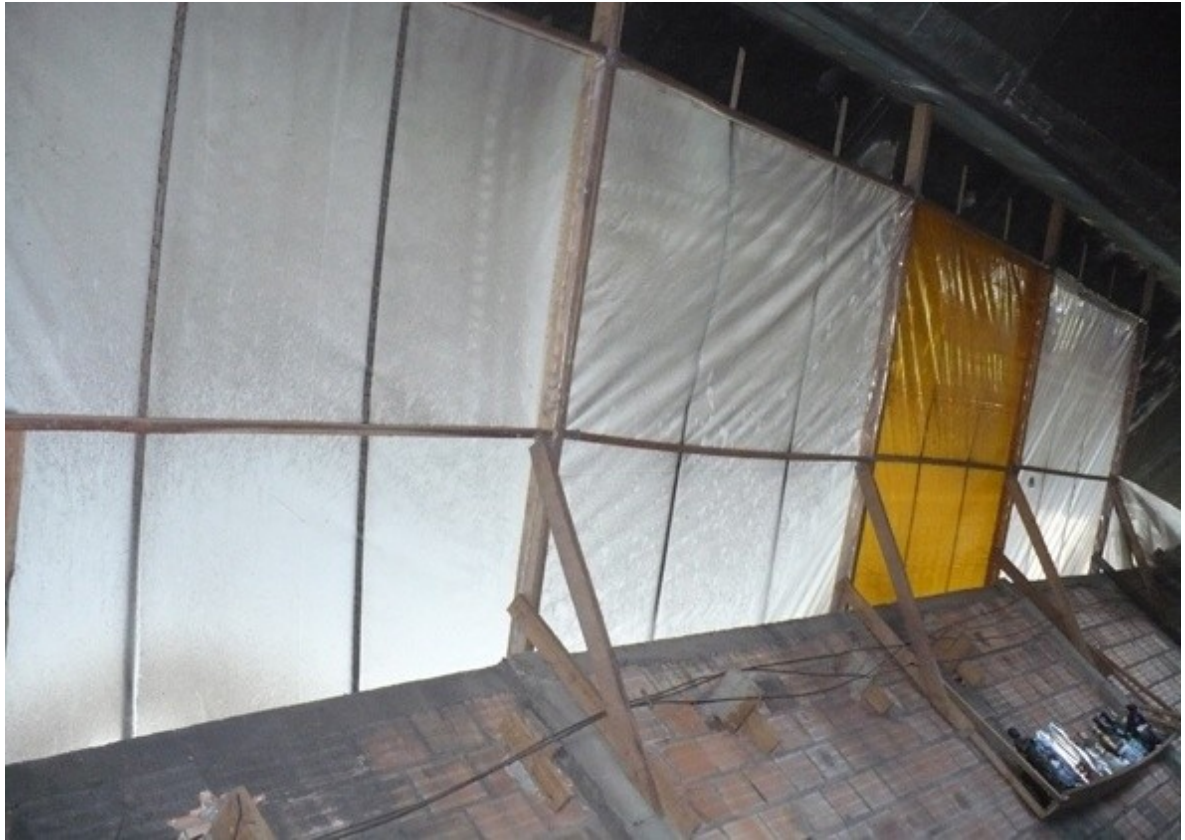
Figura 66: lona para proteção contra a chuva. Foto de André Furtado.
