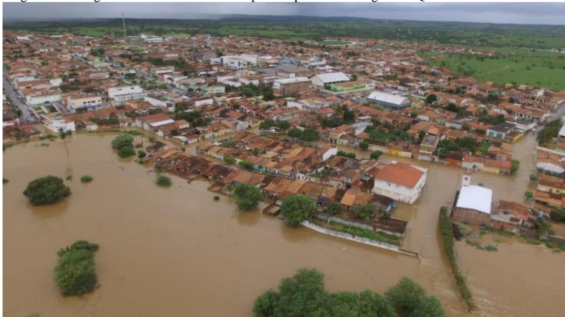
Figura 11 - Imagem de Coronel João de Sá após a ruptura da Barragem do Quati em Pedro Alexandre.
