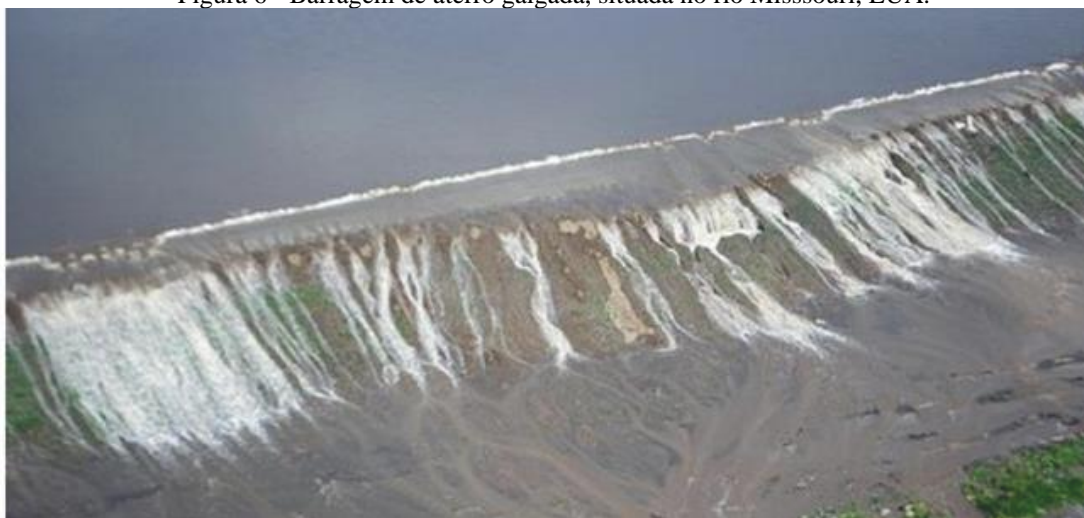
Figura 6 - Barragem de aterro galgada, situada no rio Missouri, EUA.
