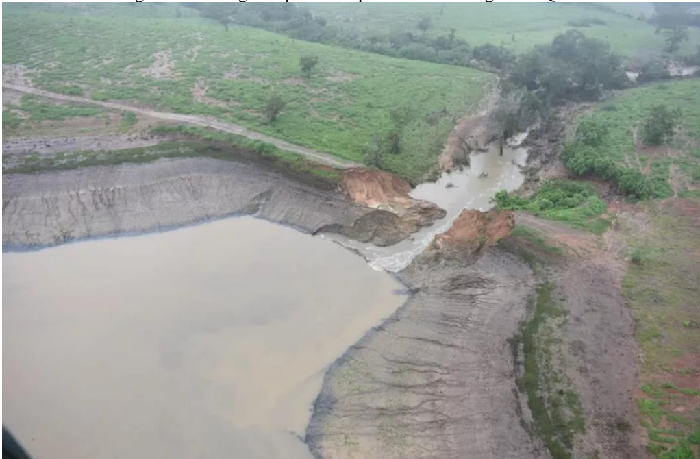
Figura 10 - Imagens após o rompimento da Barragem de Quati.
