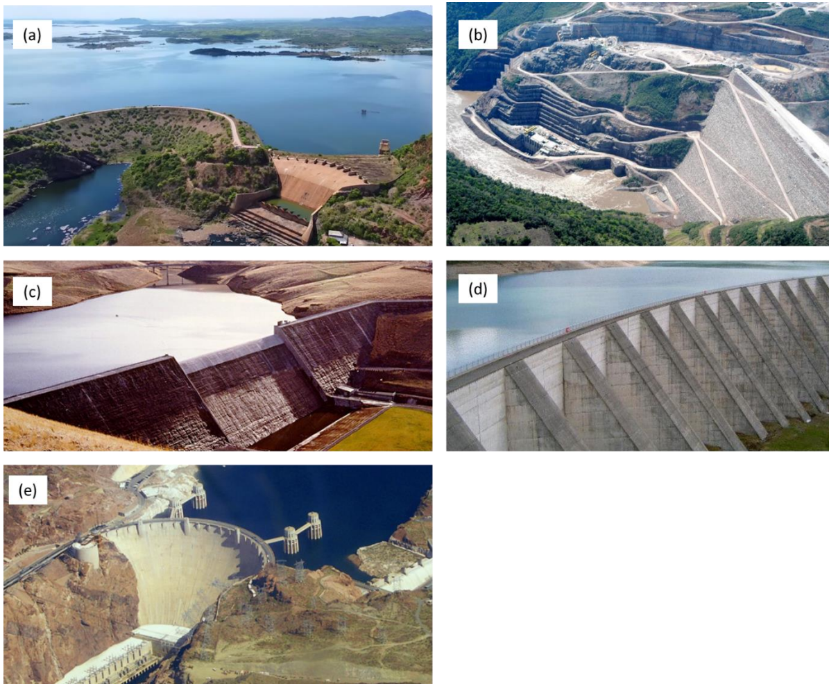
Figura 2 – Exemplificação da classificação das barragens que relaciona o tipo de material e método construtivo.
