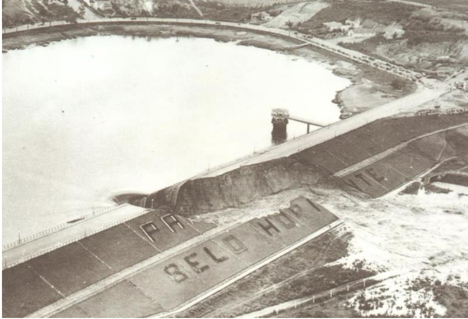
Figura 8 - Rompimento de barragem por piping.
