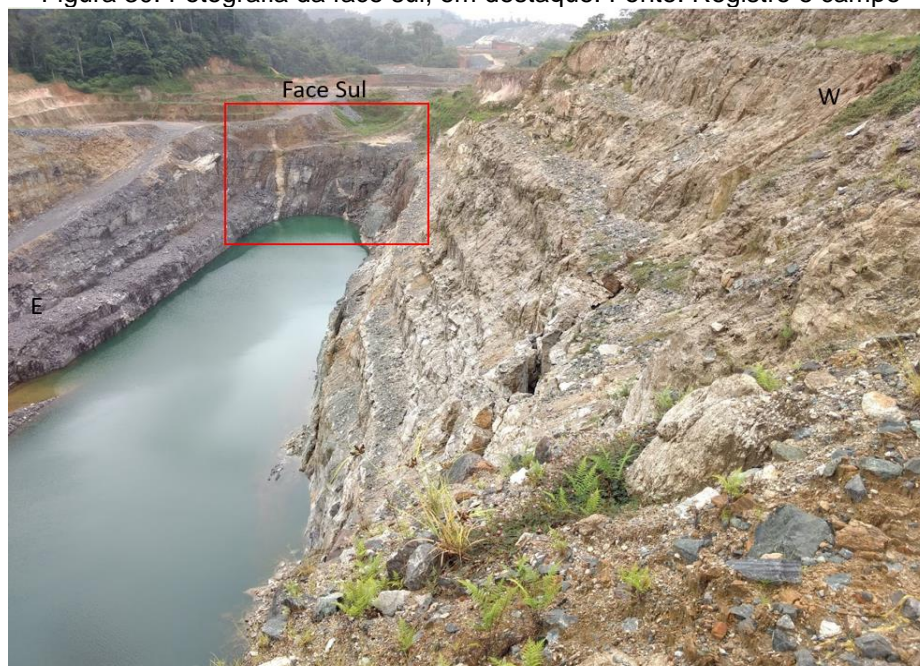
Figura 30: Fotografia da face sul, em destaque. Fonte: Registro e campo
