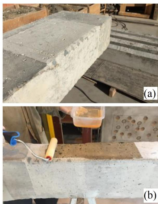
Figura 3: (a) Arredondamento dos cantos para execução da ancoragem em "U"; (b) Aplicação do primer
