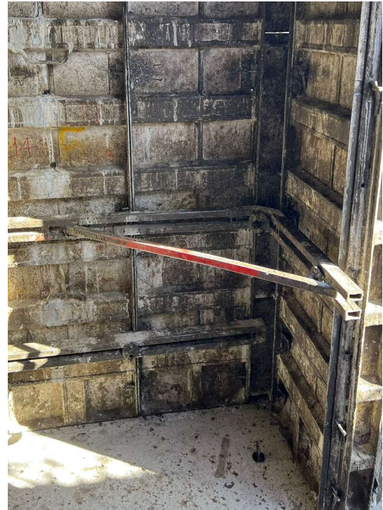
Figura 35: Alinhadores de fôrma (Fonte: o autor).
