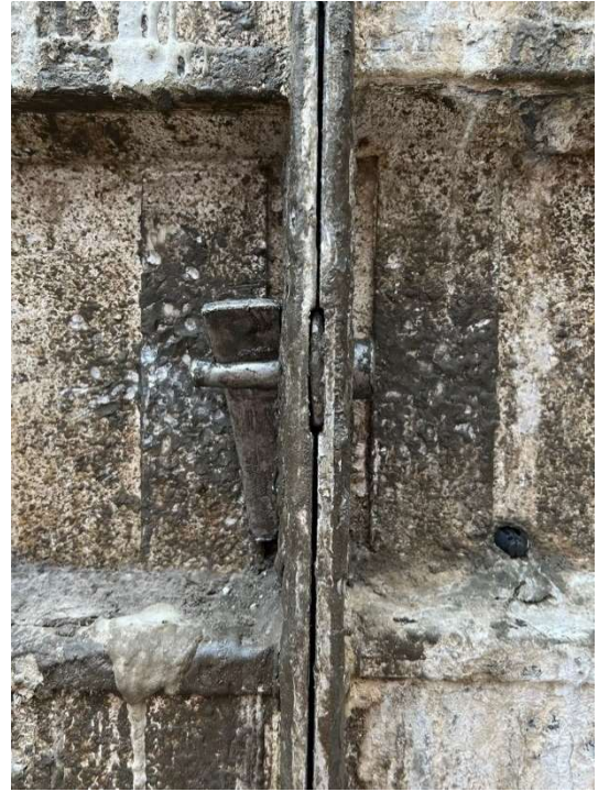
Figura 33: Corbata encunhada tipo II (Fonte: o autor).
