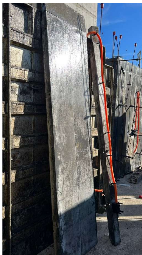
Figura 28: Placa com o desmoldante aplicado (Fonte: o autor).
