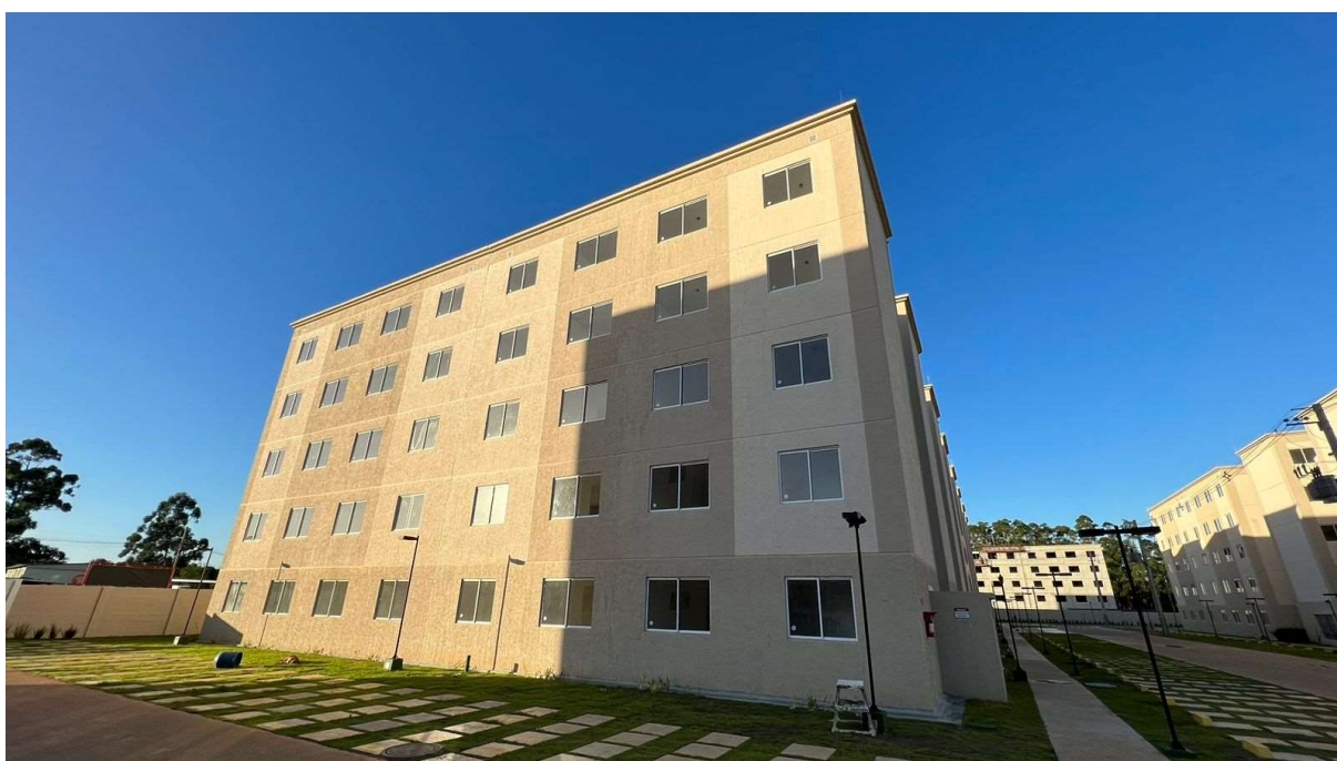
Figura 13: Torre com atividades de estrutura e acabamentos finalizadas (Fonte: o Autor).
