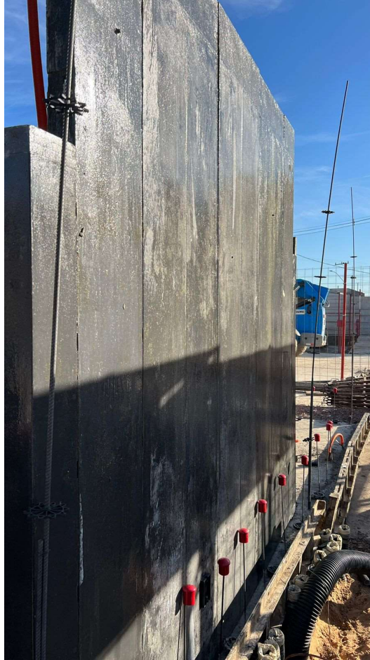
Figura 29: Primeiro lado de fôrmas montado (Fonte: o autor).
