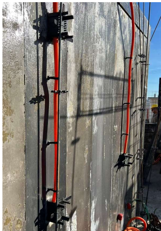
Figura 25: Mangueiras elétricas presas nos painéis através de espaçadores (Fonte: o autor).
