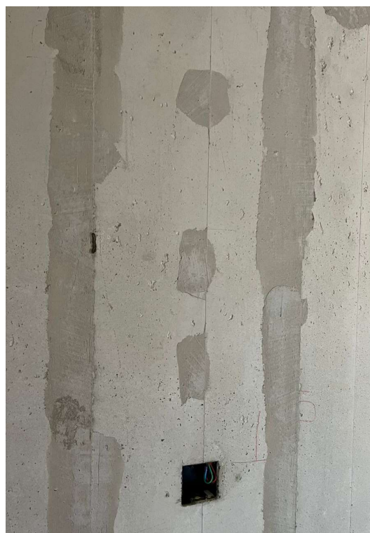
Figura 45: Pontas dos espaçadores cortadas e arrematadas na pós-concretagem (Fonte: o autor).
