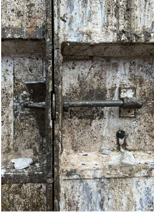
Figura 32: Corbata encunhada tipo I (Fonte: o autor).
