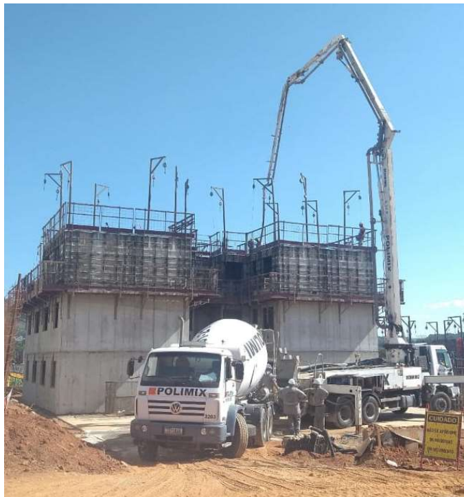
Figura 37: Concretagem com caminhão betoneira e bomba lança (Fonte: o autor).
