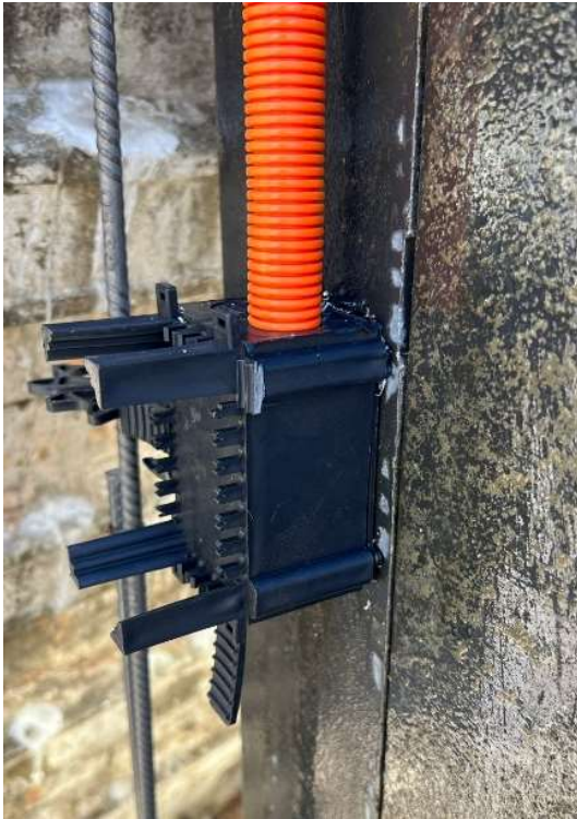
Figura 22: Caixa elétrica presa por encaixe na tampa fixada na fôrma (Fonte: o autor).
