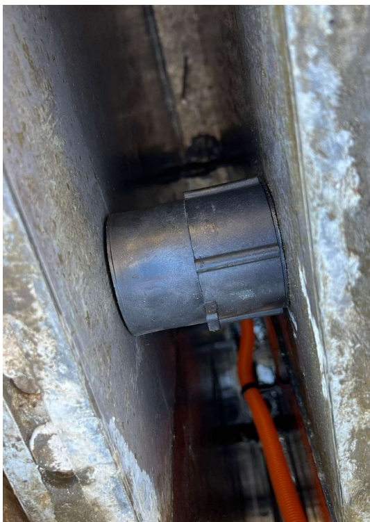
Figura 24: Passante do ar condicionado preso por encaixe nas tampas fixadas na fôrma (Fonte: o autor).
