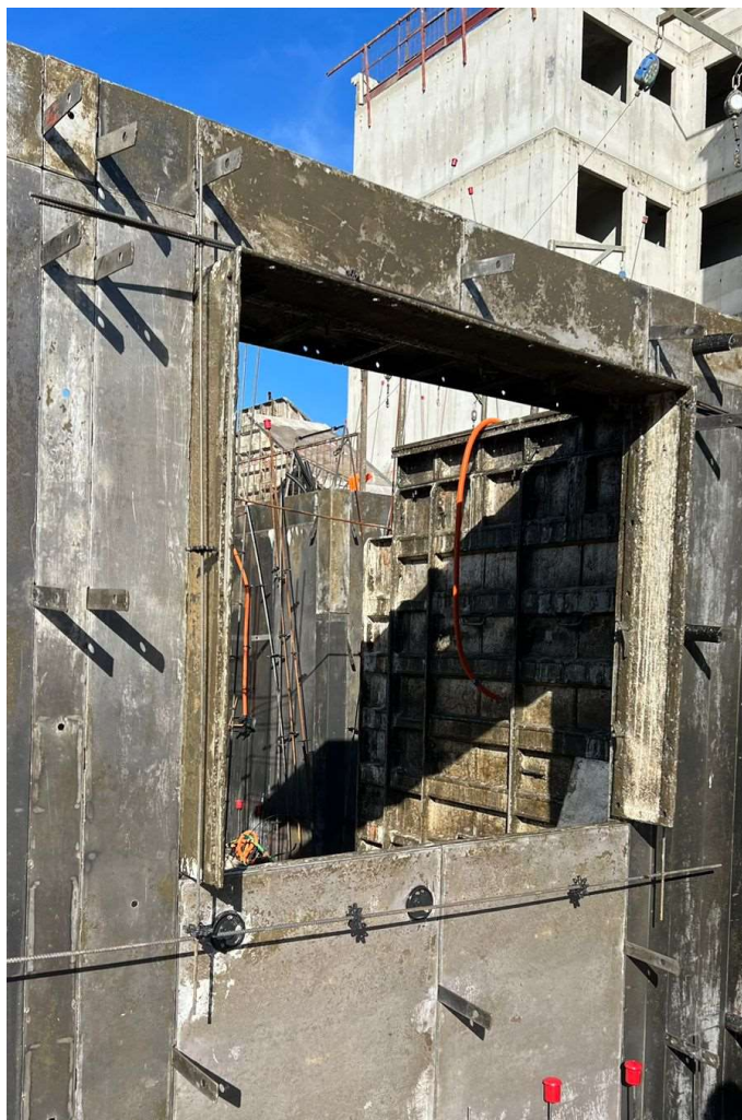
Figura 21: Moldura de reforço encaixada nos tapa-muros da janela (Fonte: o autor).
