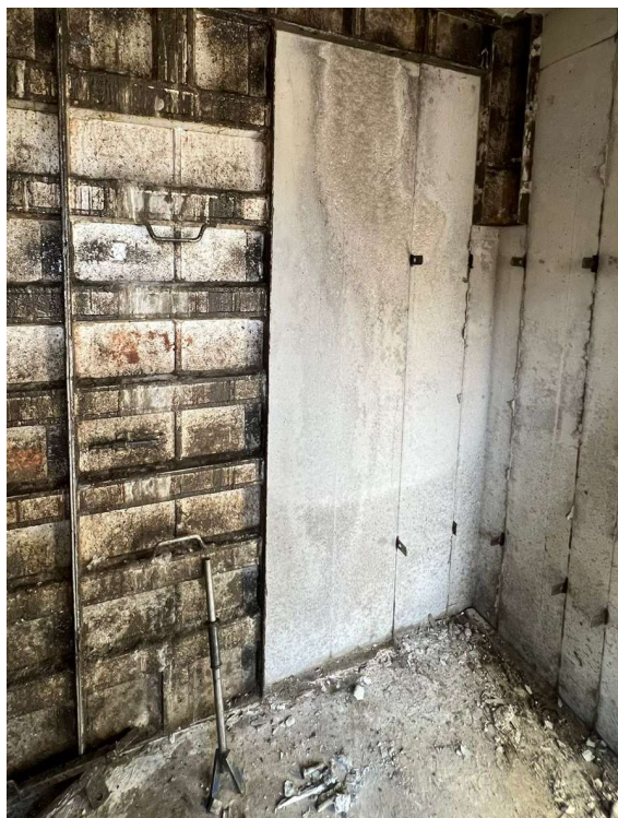
Figura 41: Parede de concreto em fase de desforma (Fonte: o autor).
