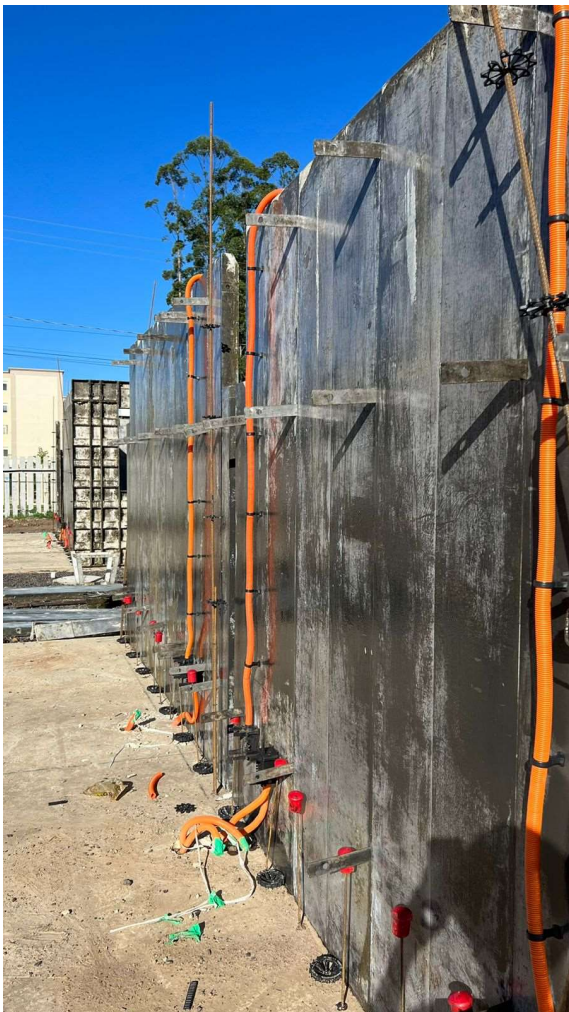
Figura 30: Colocação das corbatas (Fonte: o autor).
