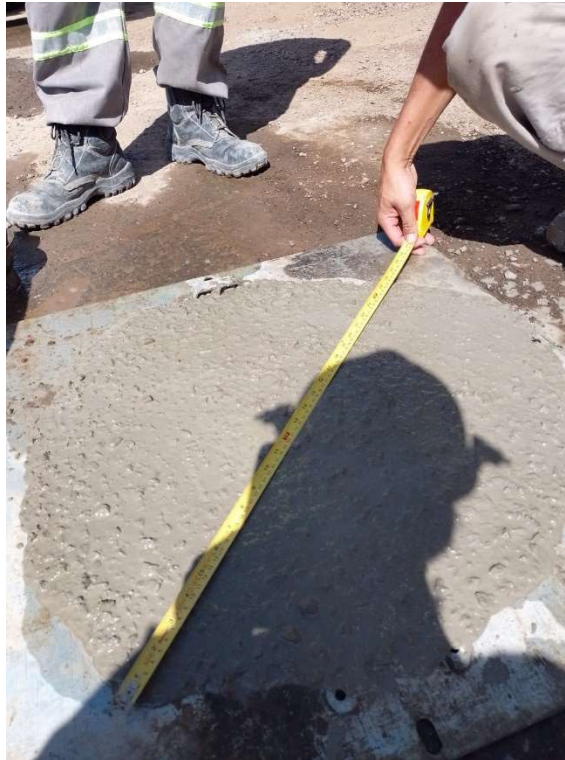
Figura 38: Flow test do concreto autoadensável (Fonte: o autor).
