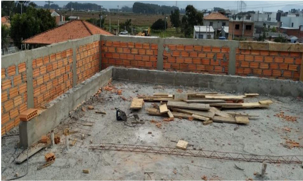
Figura 16 - elemento estrutural de vigamento invertido - vista superior
