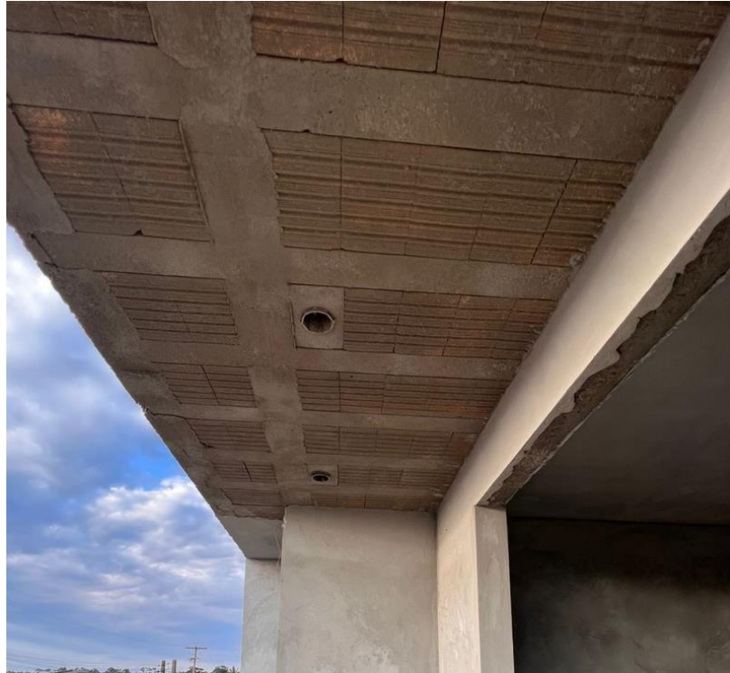
Figura 18 - elemento estrutural de vigamento invertido - vista inferior
