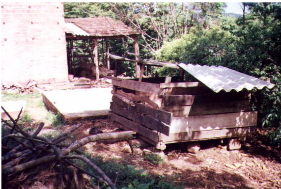
FOTO 10 – Melhoria de infra-estrutura. Construção de pocilga de alvenaria para substituir o chiqueiro de madeira.
