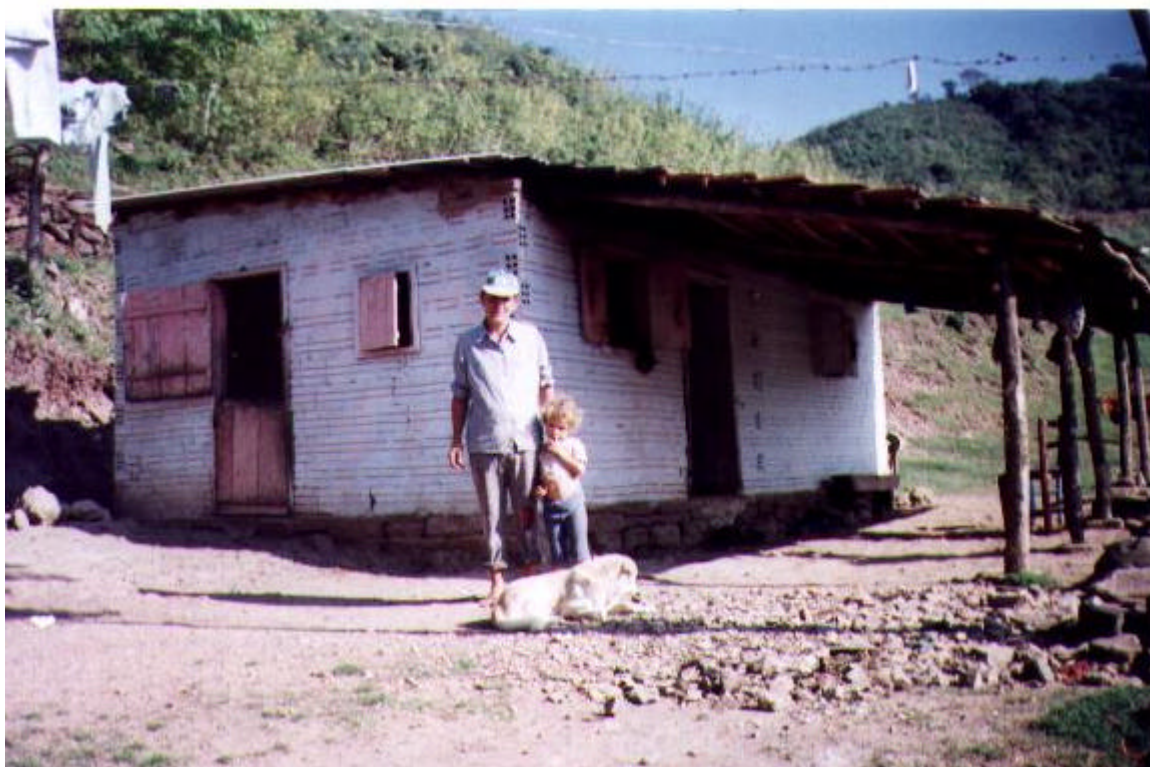
FOTO 5 – Moradia de agricultor não integrado na região de relevo acidentado.
