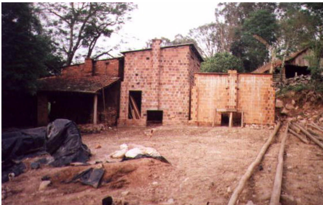
FOTO 9 – Melhoria de estufas. Construção de estufa com ar forçado.
