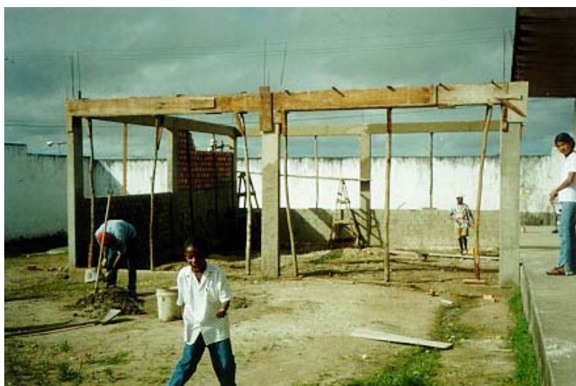
FIGURA 28 CONSTRUÇÃO DO PÁTIO COBERTO
