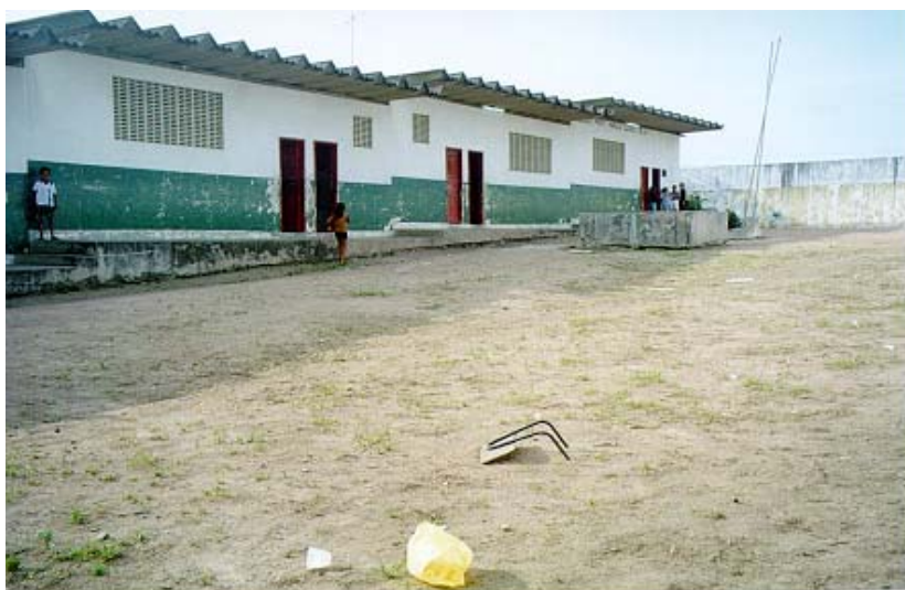
FIGURA 17 – FACHADA DA ESCOLA PROF A . MARÍLIA QUEIRÓZ
