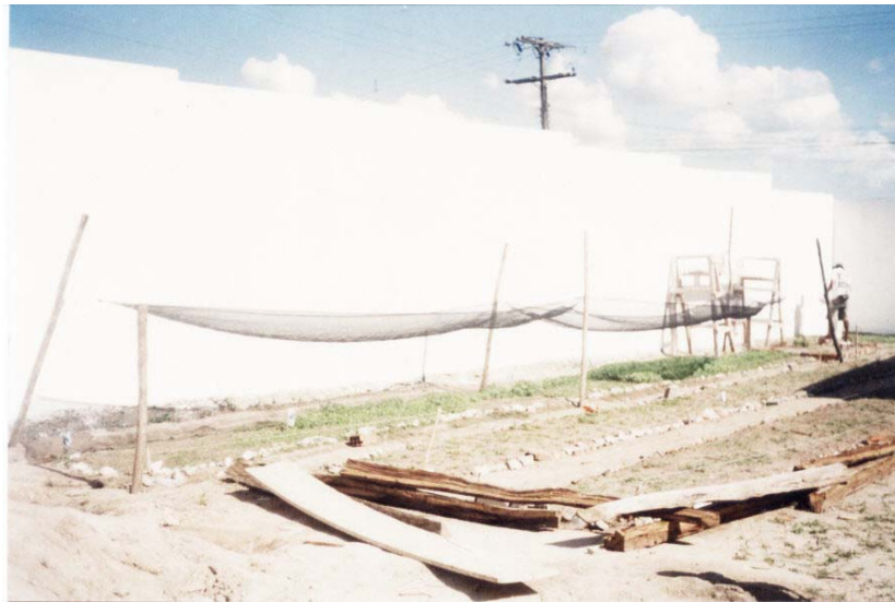
FIGURA 32 VISTA DO MURO
