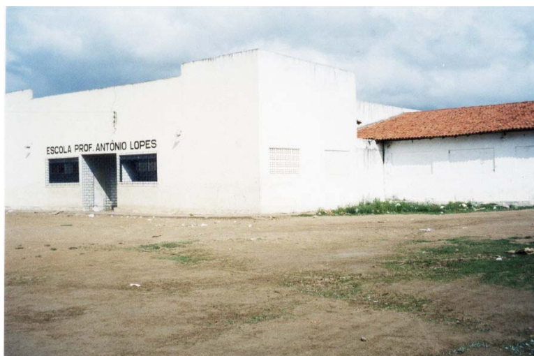
FIGURA 12 – VISTA DA ESCOLA PROF. ANTÔNIO LOPES
