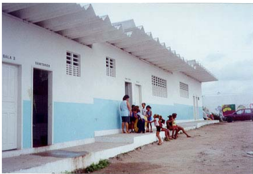
FIGURA 31 PINTURA DA FACHADA E DA COBERTURA
