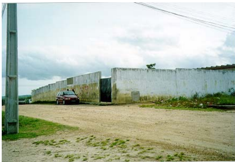
FIGURA 20 – VISTA EXTERNA DO MURO DA ESCOLA
