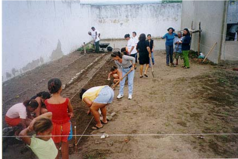
FIGURA 23 CONSTRUÇÃO DAS LEIRAS DA HORTA
