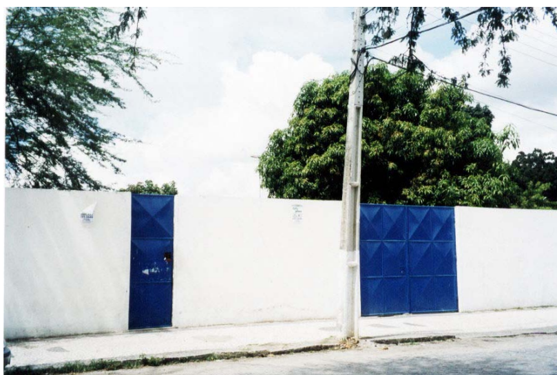
FIGURA 14 – VISTA DA ESCOLA MONTEIRO LOBATO
