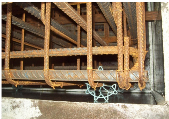
Figura 8: espaçador tipo roseta
