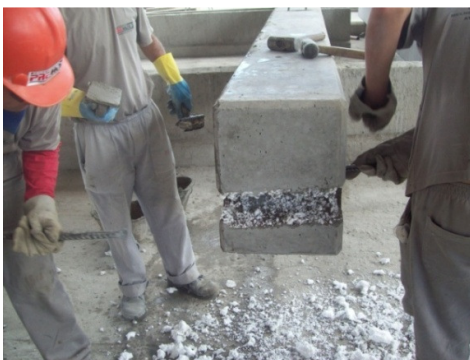
Figura 18: retirada de isopor dos cantos
