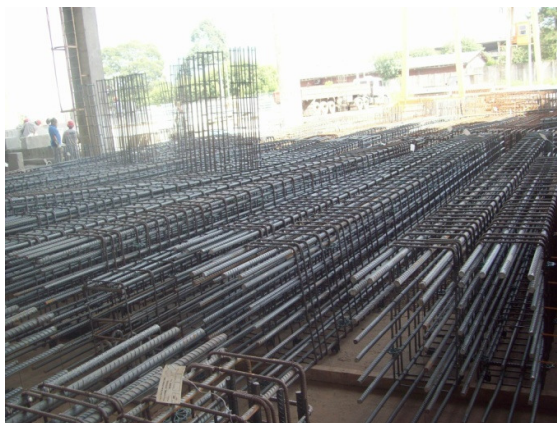
Figura 10: estocagem de armadura no pátio
