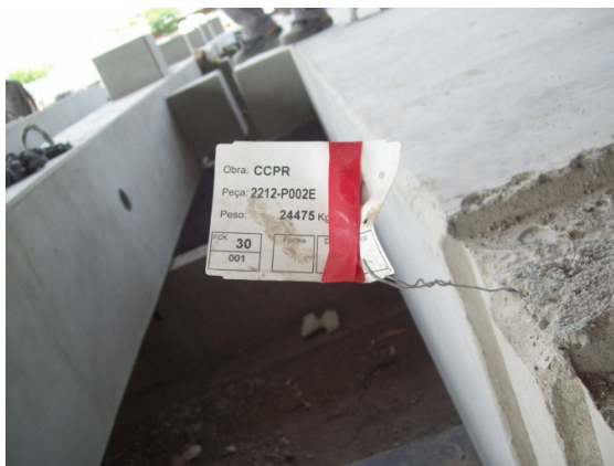
Figura 20: peça reprovada na verificação dimensional
