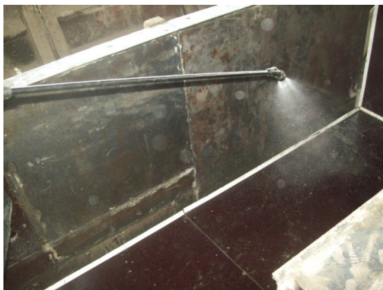
Figura 12: aplicação de óleo desmoldante
