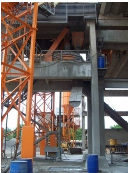
Figura 13: central de concreto
