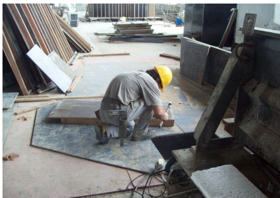
Figura 11: montagem da fôrma
