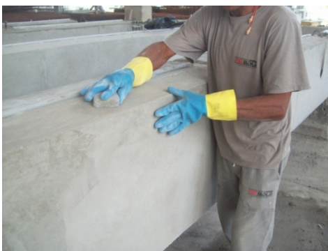
Figura 17: acabamento dos chanfros com pedra de polir
