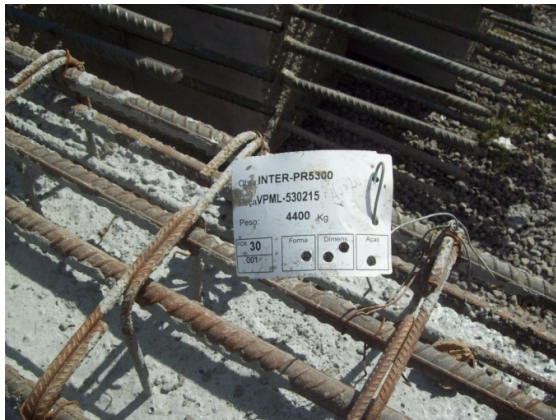
Figura 19: furos na etiqueta da peça pronta
