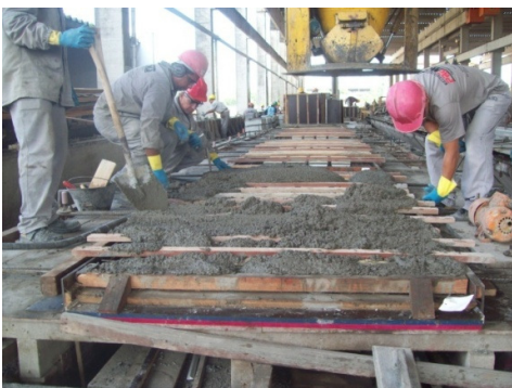
Figura 15: concretagem da peça através de mangote vibrador
