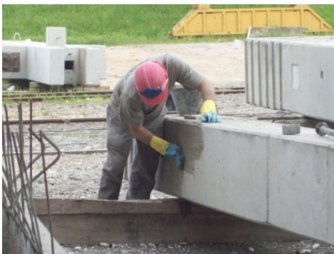
Figura 16: nateamento da superfície
