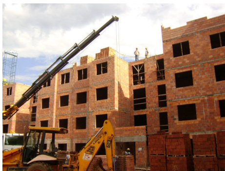
Figura 24: transporte de unidades com guindaste hidráulico na obra B
