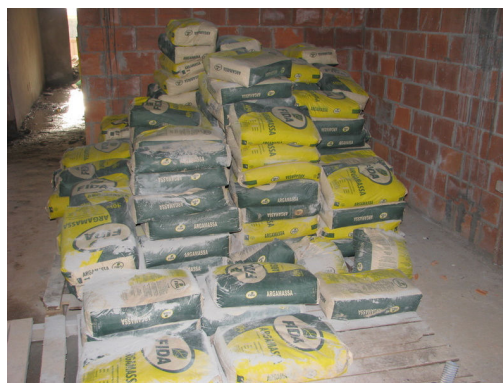
Figura 26: estoque de argamassa industrializada na obra B
