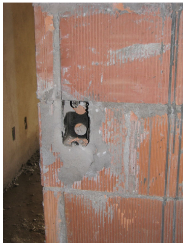
Figura 39: instalação de caixa de passagem elétrica na obra B
