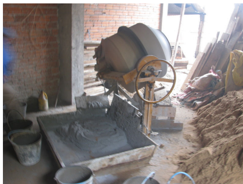
Figura 25: central de argamassa da obra A1
