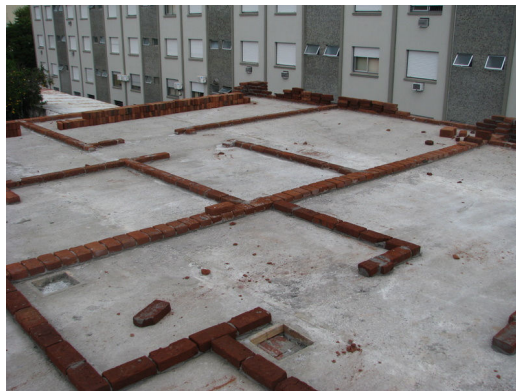
Figura 19: vista da obra A2
