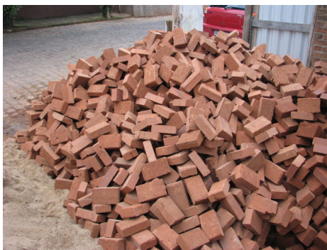
Figura 23: tijolos maciços cerâmicos descarregados com caminhão de caçamba basculante na obra A2
