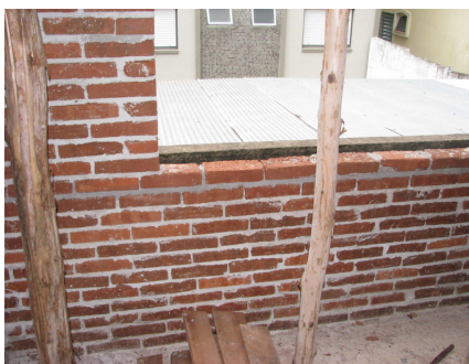
Figura 34: reforço com armadura no interior da junta de argamassa sob as janelas na obra A2
