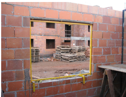
Figura 33: verga e contra verga executadas com bloco canaleta e gabarito metálico na obra B
