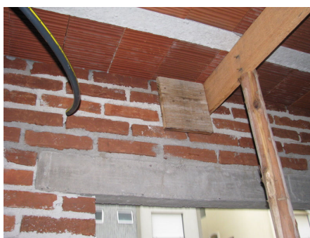
Figura 36: verga e apoio da laje na obra A2
