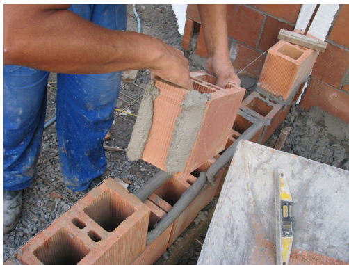
Figura 22: bloco cerâmico estrutural de 15 MPa utilizado na obra B
