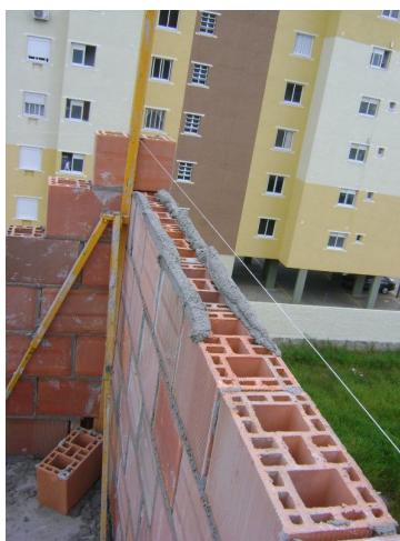
Figura 30: cordões de argamassa aplicados nos blocos de 10 MPa da obra B
