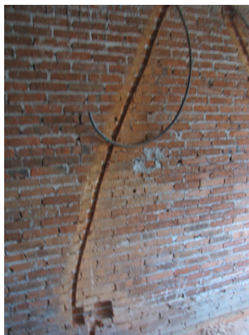
Figura 38: canaleta para embutimento de eletroduto na obra A2
