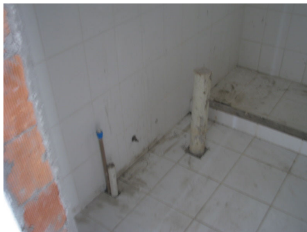
Figura 41: instalação de alguns tubos hidráulicos externos à parede na obra B
