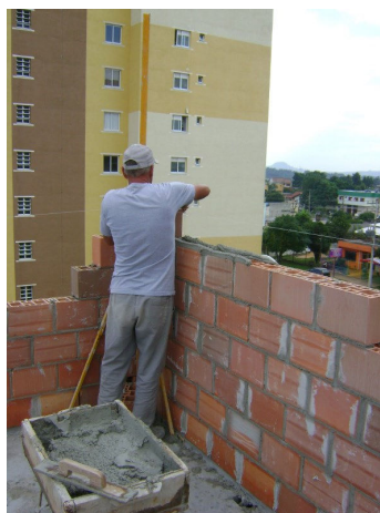
Figura 28: assentamento de unidades com auxílio do escantilhão na obra B
