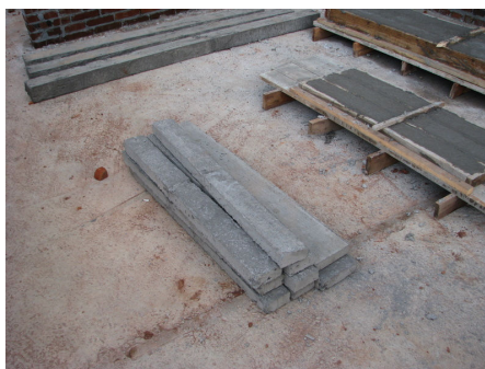
Figura 32: produção das vergas pré moldadas na obra A2
