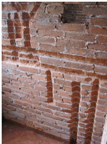
Figura 40: canaletas para a instalação de tubulações hidráulicas na obra A1
