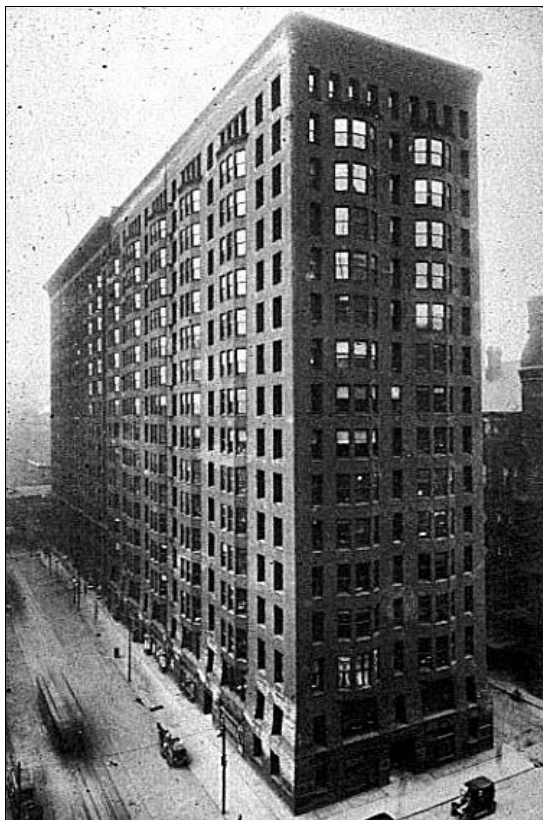
Figura 2: edifício Monadnock (WEINEL, 2009)
