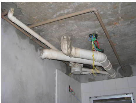
Figura 43: instalação de tubos hidráulicos sob a laje na obra B
