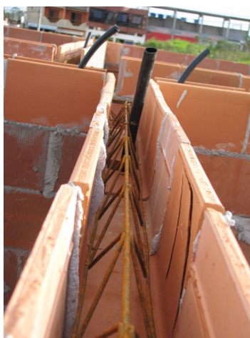
Figura 35: cinta de respaldo executada com bloco canaleta na obra B
