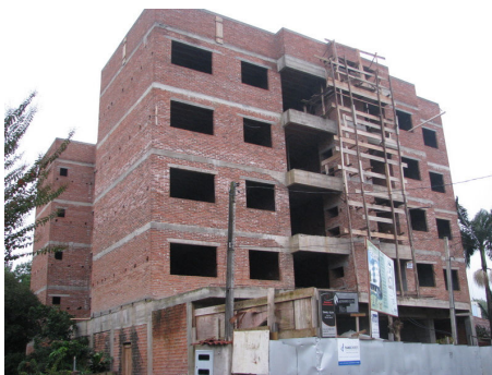
Figura 18: vista da obra A1
