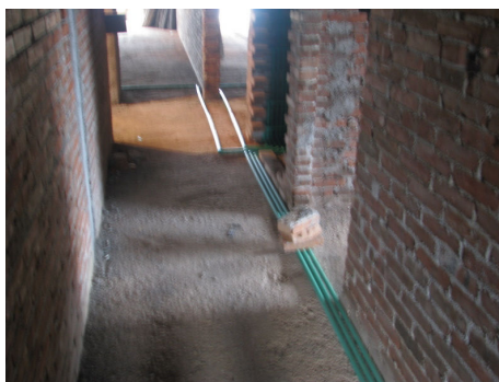
Figura 42: tubos de alta resistência instalados sobre a laje na obra A1
