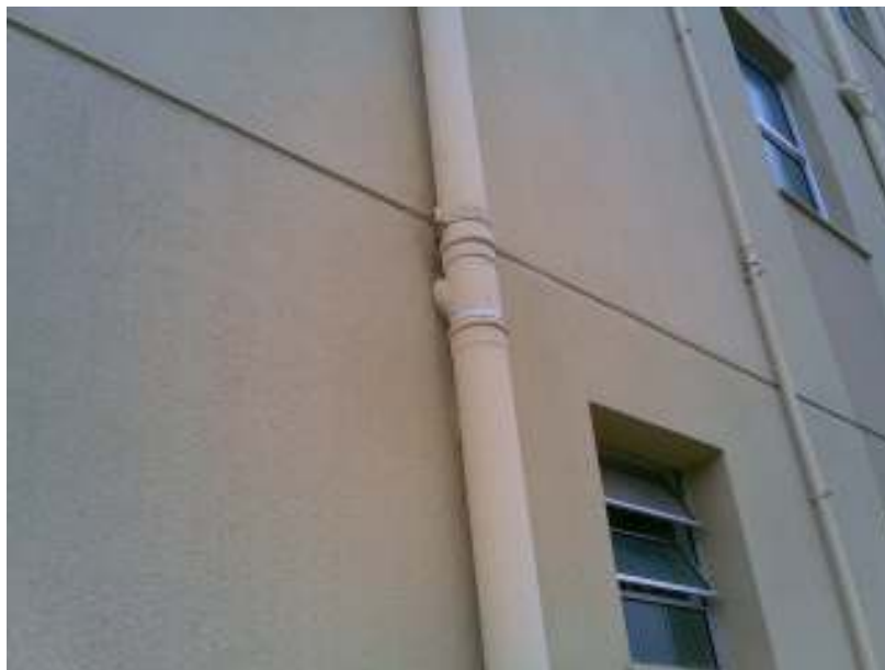
Figura 10: PVC exposto em função da movimentação da justa elástica
