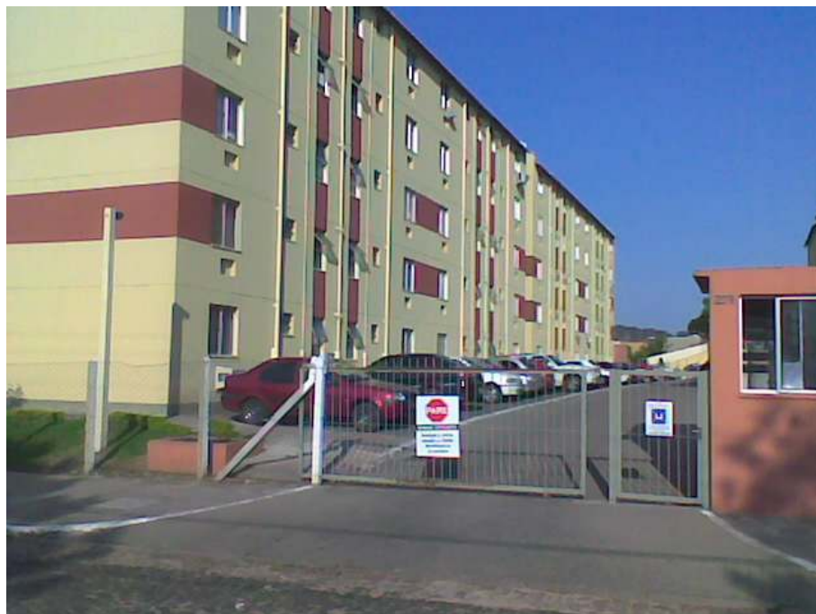
Figura 3: fachada do edifício em estudo com as tubulações fixadas na fachada
