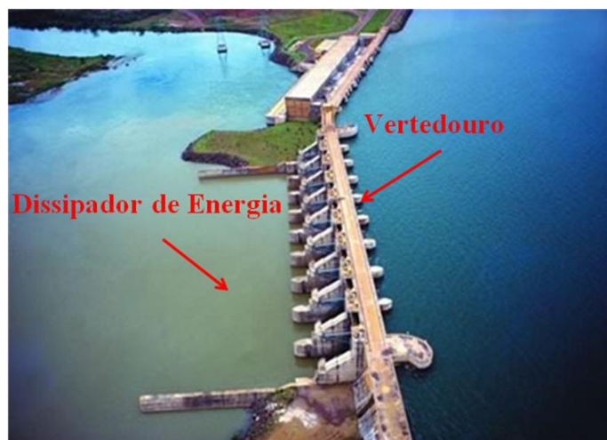
Figura 3: exemplo de sistema extravasor da Usina Hidrelétrica de Porto Colômbia com dissipador de energia do tipo bacia de dissipação por ressalto hidráulico tipo I (FURNAS, 2010)
