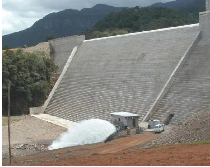
Figura 11: vertedouro em degraus (VERTEDOUROS..., 2010)
