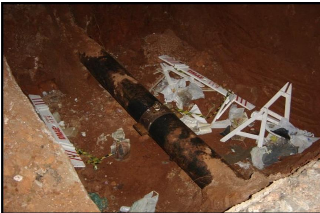
Figura 23: Fotografia noturna da escavação onde rompeu a adutora do DMAE
