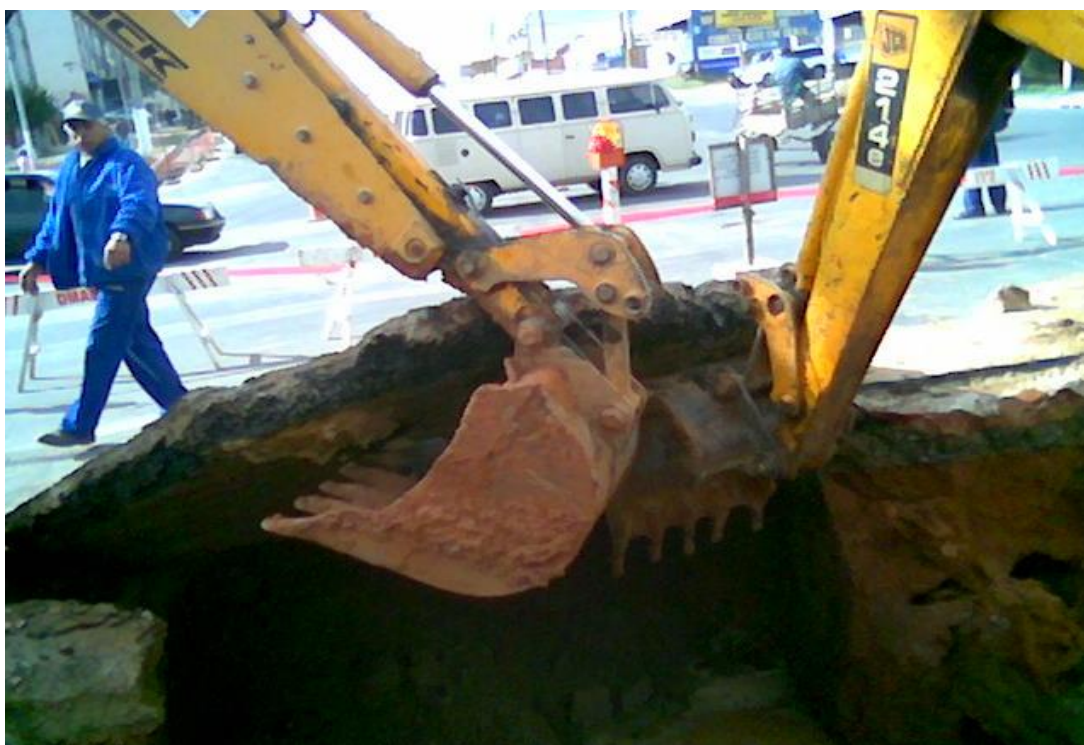
Figura 22: Trabalho de escavação do leito viário com retro escavadeiras
