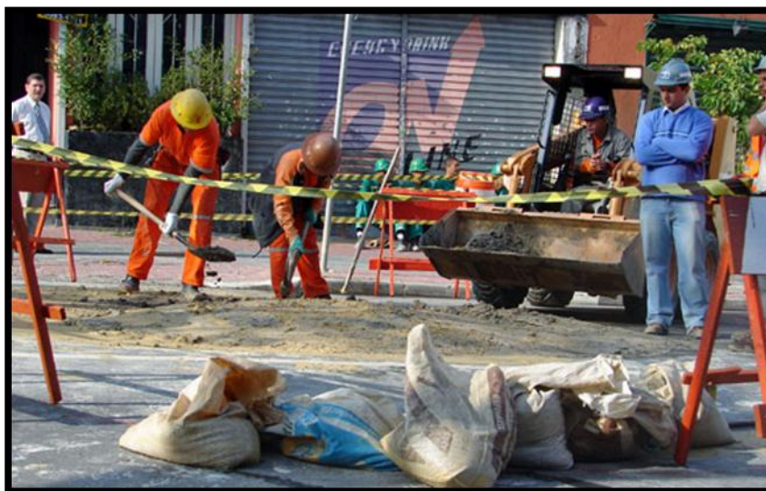
Figura 11: Sinalização de trabalho com isolamento por fita zebra e cavaletes
