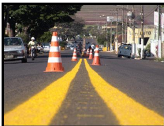
Figura 5: Sinalização horizontal tipo LMS-2 (linha simples seccionada)
