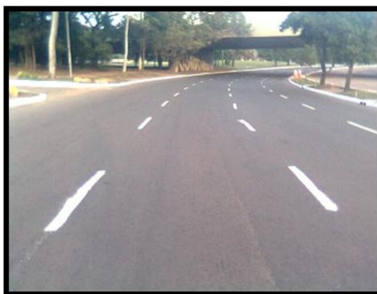
Figura 5: Sinalização horizontal tipo LMS-2 (linha simples seccionada)
