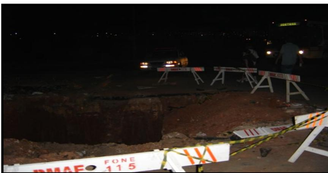
Figura 23: Fotografia noturna da escavação onde rompeu a adutora do DMAE
