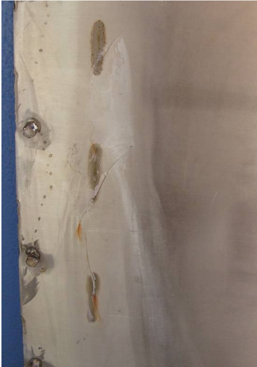
Figura 4 – Vista frontal da chapa do defletor.
