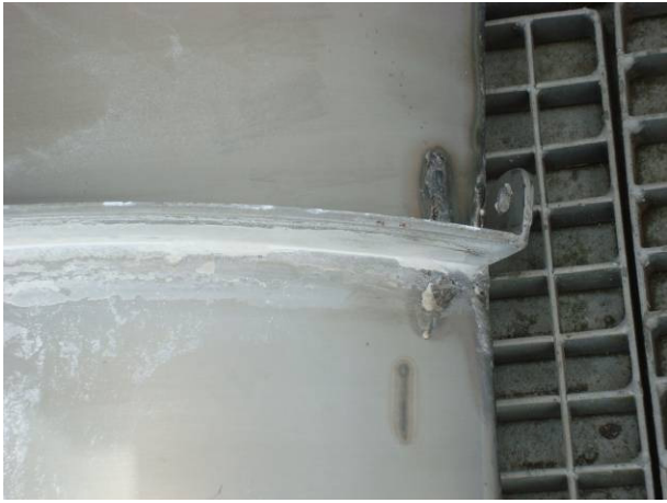
Figura 7 (esquerda) – Fratura ocorrida na porção intermediária do elemento semi-circular. Reparada com solda e coberta por um reforço. Figura 8 (direita) – Fratura na porção intermediária de elemento semi-circular, reparada com solda.
