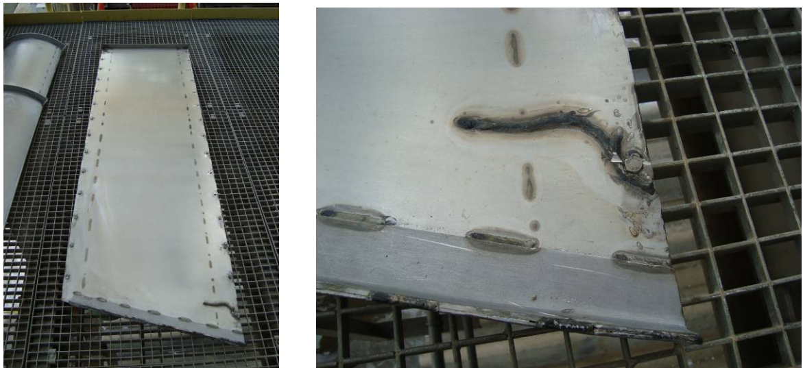
Figuras 3 e 4 – Fratura na porção inferior do componente.
