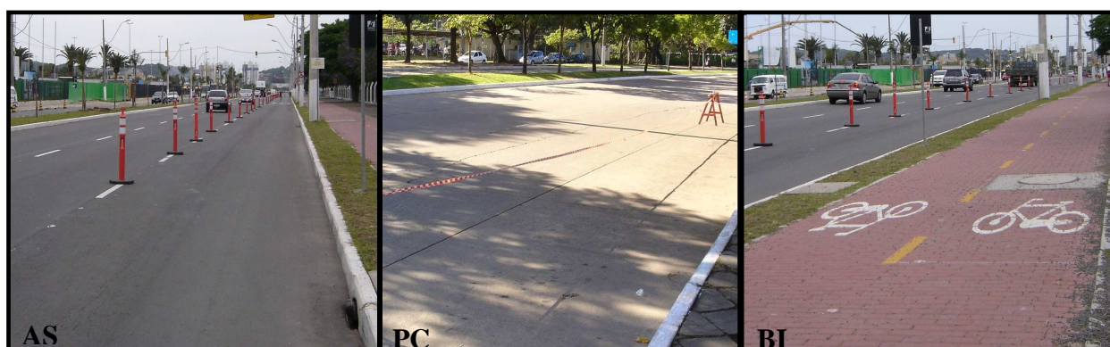
Figura 8 - Tipos de pavimentação empregados nas medições: asfalto (AS), placas moldadas “ in loco ” de concreto (PC) e blocos intertravados de concreto (BI).
