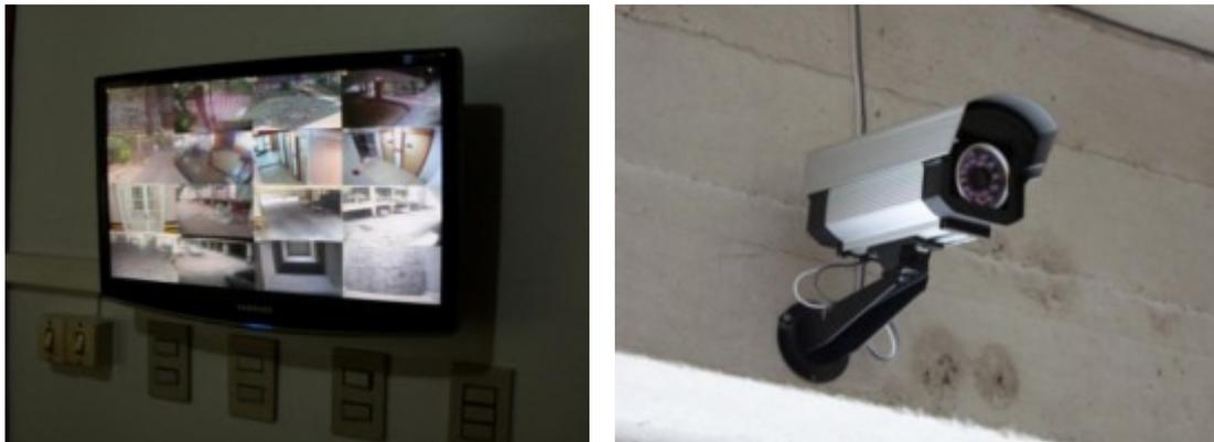
**Figura 2.1.13: Central de segurança digital e câmera com sensor IR
