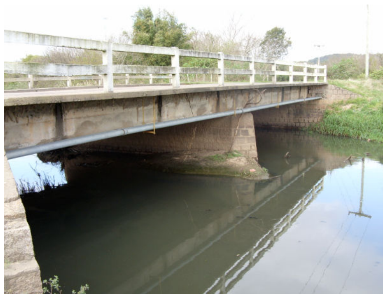
FIG. 34 – PONTE NA AVENIDA DA SERRARIA
