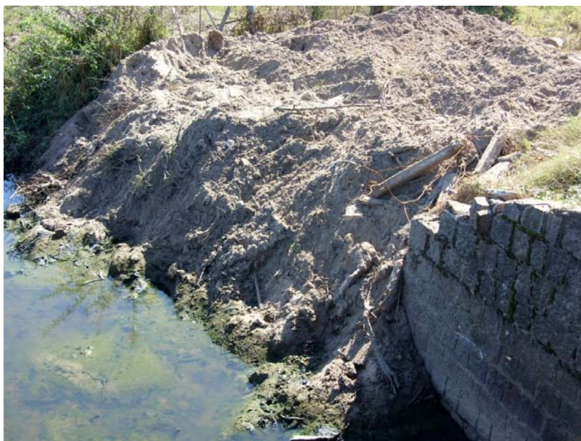
FIG. 15 – DRAGAGEM DO ARROIO DO SALSO (04/05/2009)
