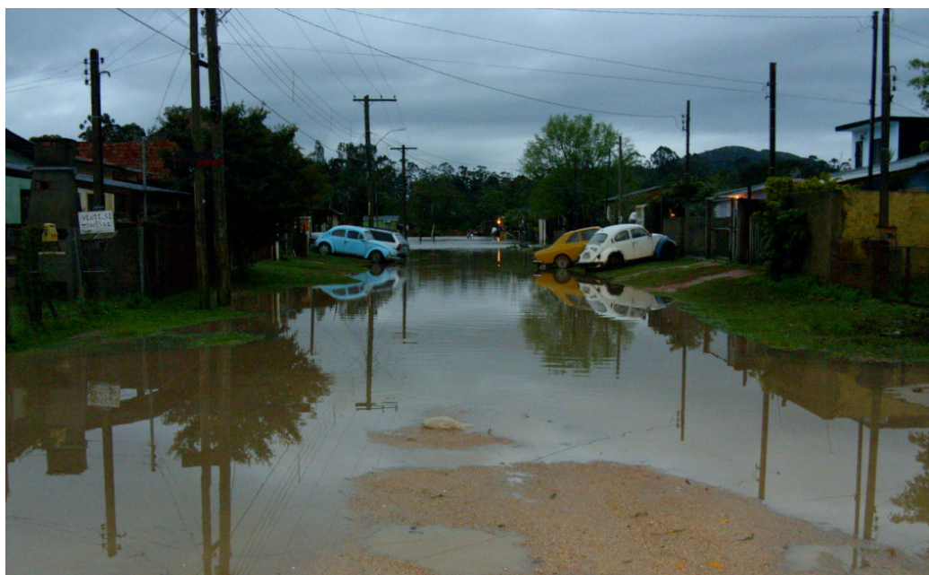
FIG. 09 – INUNDAÇÃO NO TÚNEL VERDE (12/09/2009)
