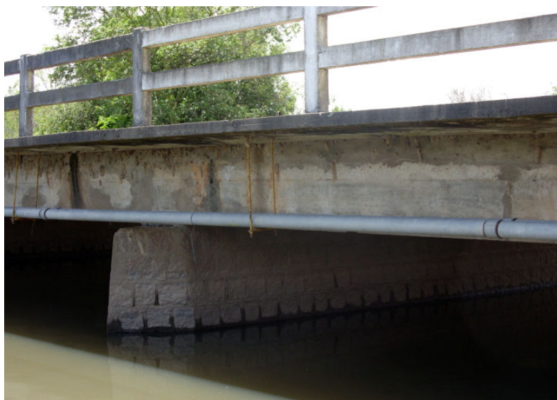
FIG. 36 – DETALHE DA PONTE NA AVENIDA DA SERRARIA
