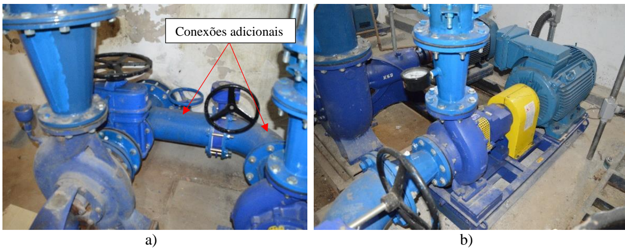
Figura 3.- a) Conexão na sucção da bomba hidráulica; b) Novo conjunto motobomba instalado.
