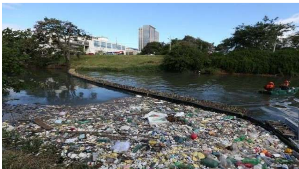
Figure 3.4 – Barreira flutuante de contenção em resíduos sólidos no Arroio Dilúvio, localizada na região metropolitana de Porto Alegre - RS.
