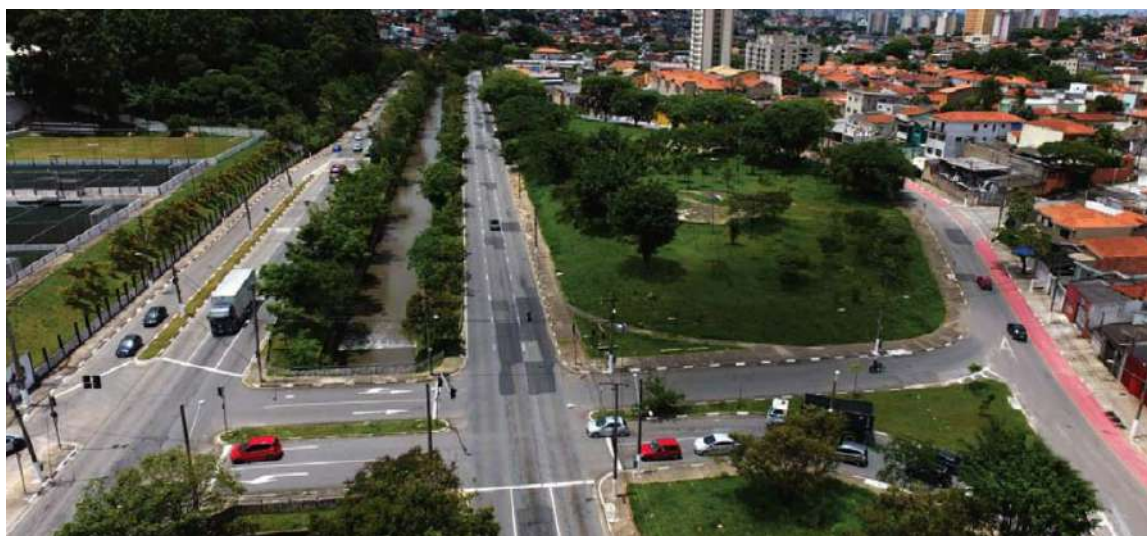
Figure 3.14 – Situação atual do reservatório in-line da AV. Politécnica.
