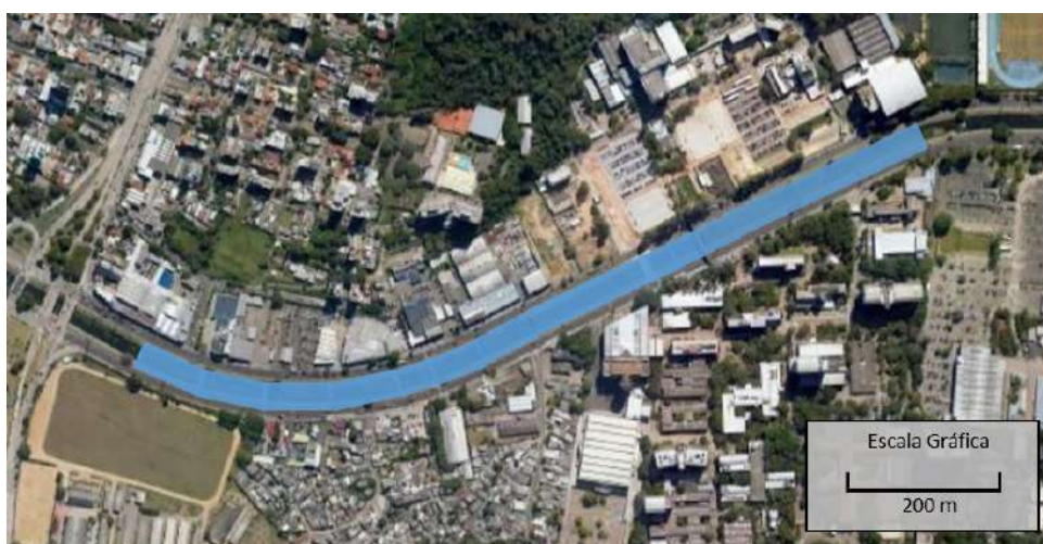
Figure 5.4 – Trecho médio adotado de 1km do arroio Dilúvio.
