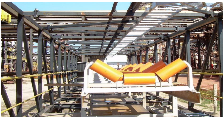
Figura 3.10. Montagem de Galeria De Aço Para Transportador de Correia (fonte Tecnologia em Movimentação SA/2006)
