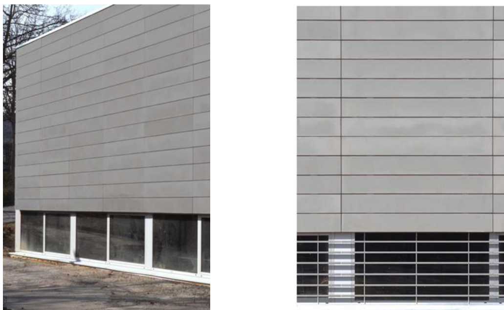
Figura 30 – Instituto de Concreto Estrutural, Aachen, Alemanha.
