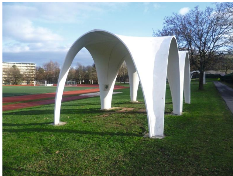
Figura 19 - Pavilhão em concreto têxtil (malha de fibra de carbono), Chemnitz, Alemanha
