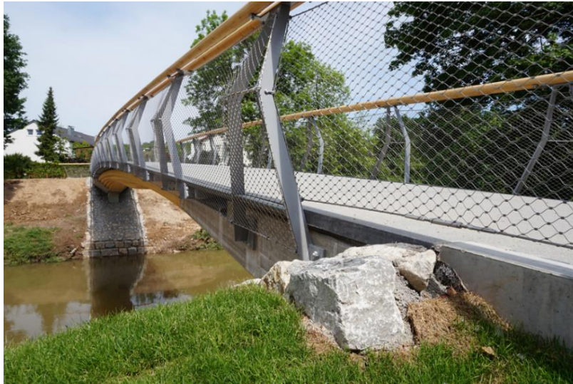
Figura 18 - Ponte pedestres e ciclistas, Weinstadt, Alemanha
