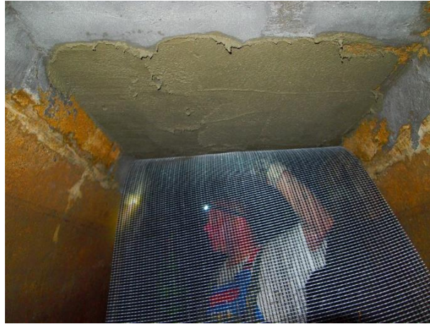
Figura 14 – Reforço de estruturas
