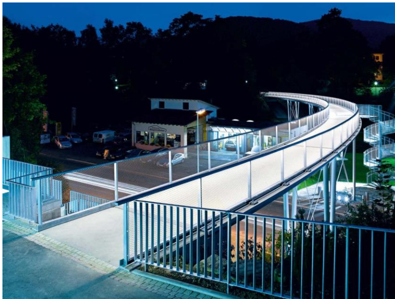
Figura 177 – Passarela em concreto têxtil, Albstadt, Alemanha.
