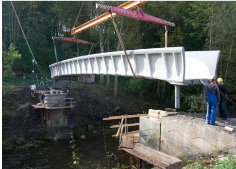
Figura 16 - Ponte para pedestres, ciclistas e small snow-cleaner , Kempten, Alemanha
