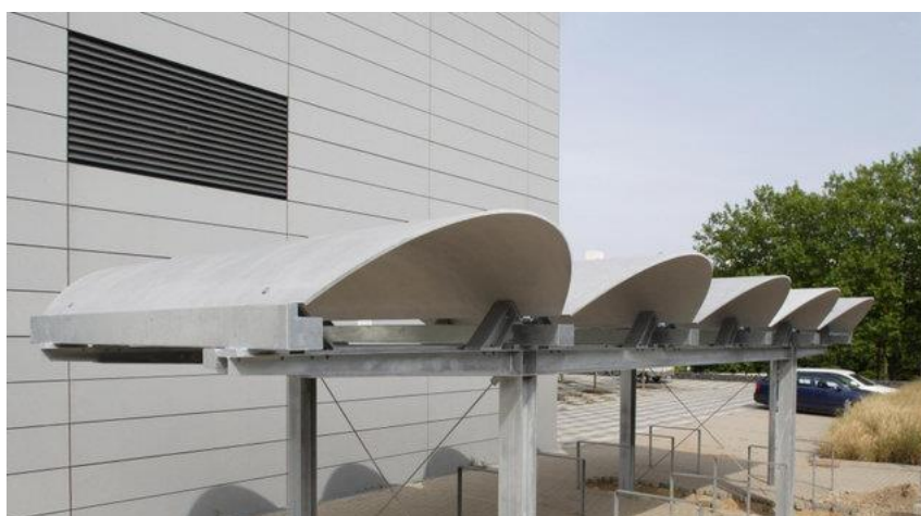
Figura 13 – Cobertura do tipo casca para bicicletas, Aachen, Alemanha
