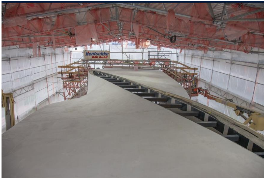
Figura 21 - Segunda etapa da parede-telhado simultâneo, batizada como “ twist ”
