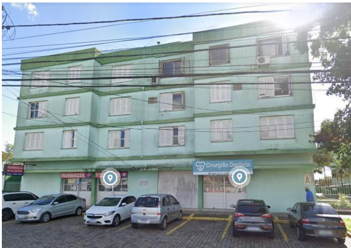
Figura 1: Fachada do prédio estudado
