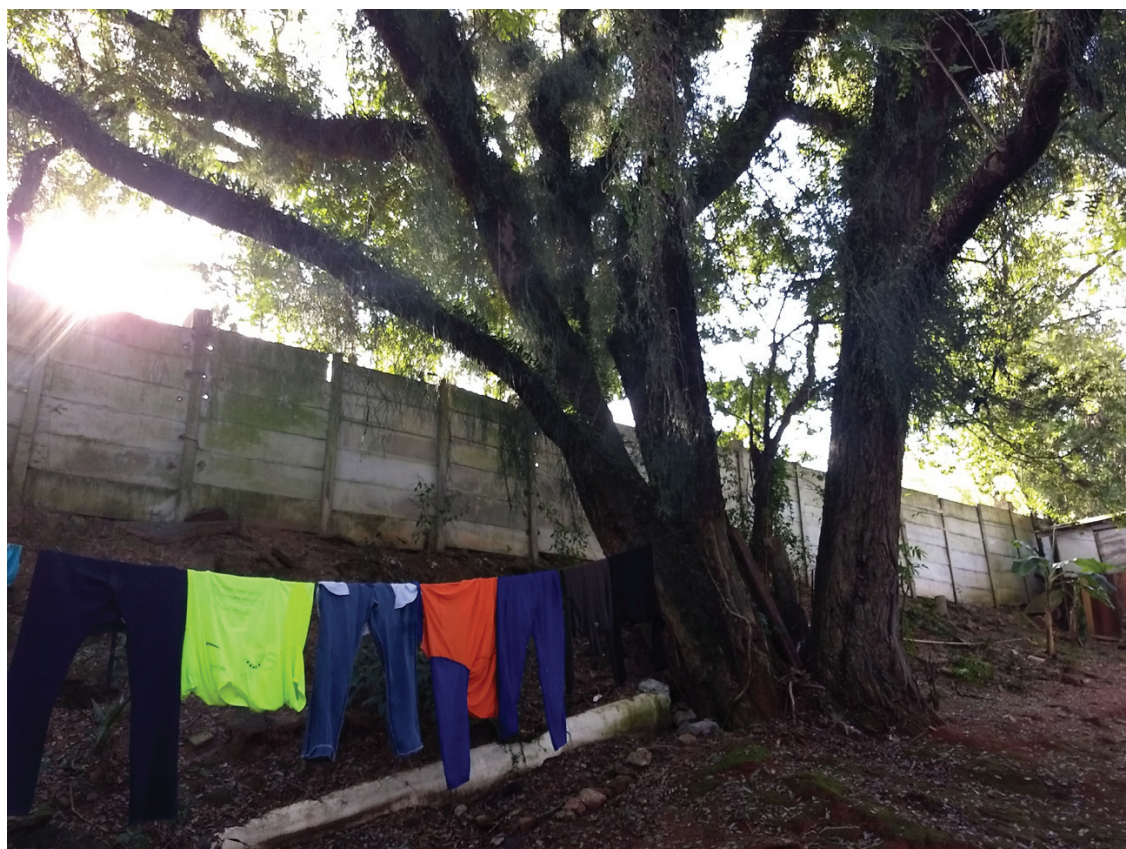
Figura 7 – Muro construído em 2015, pela Fundação Marista. Fonte: NEGA (2019)
