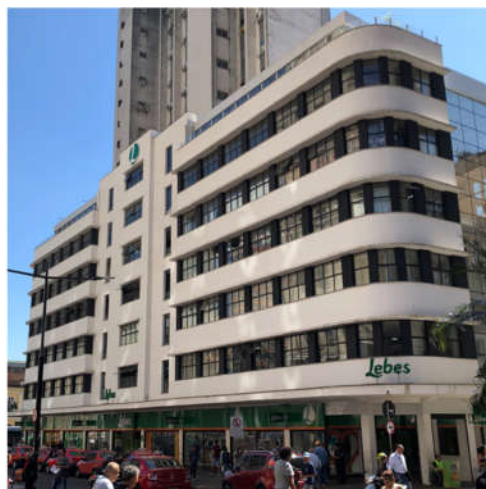
Figura 2 – Edifício Guaspari em 2018, 1 ano após a finalização da reforma que contemplou aplicação de argamassa de revestimento de cor branca com adição de \text{TiO}_2 às fachadas
