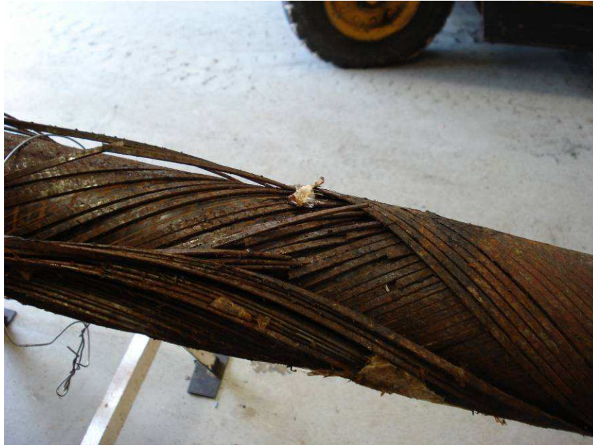
Figura 6-4. Observação das armaduras após a remoção da capa externa.
