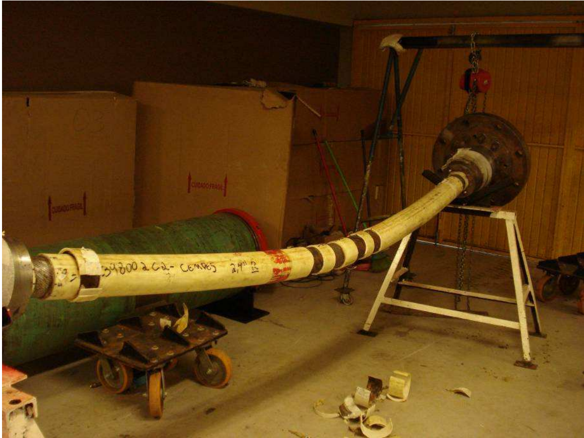
Figura 6-2. Remoção de trechos da capa de polímero
