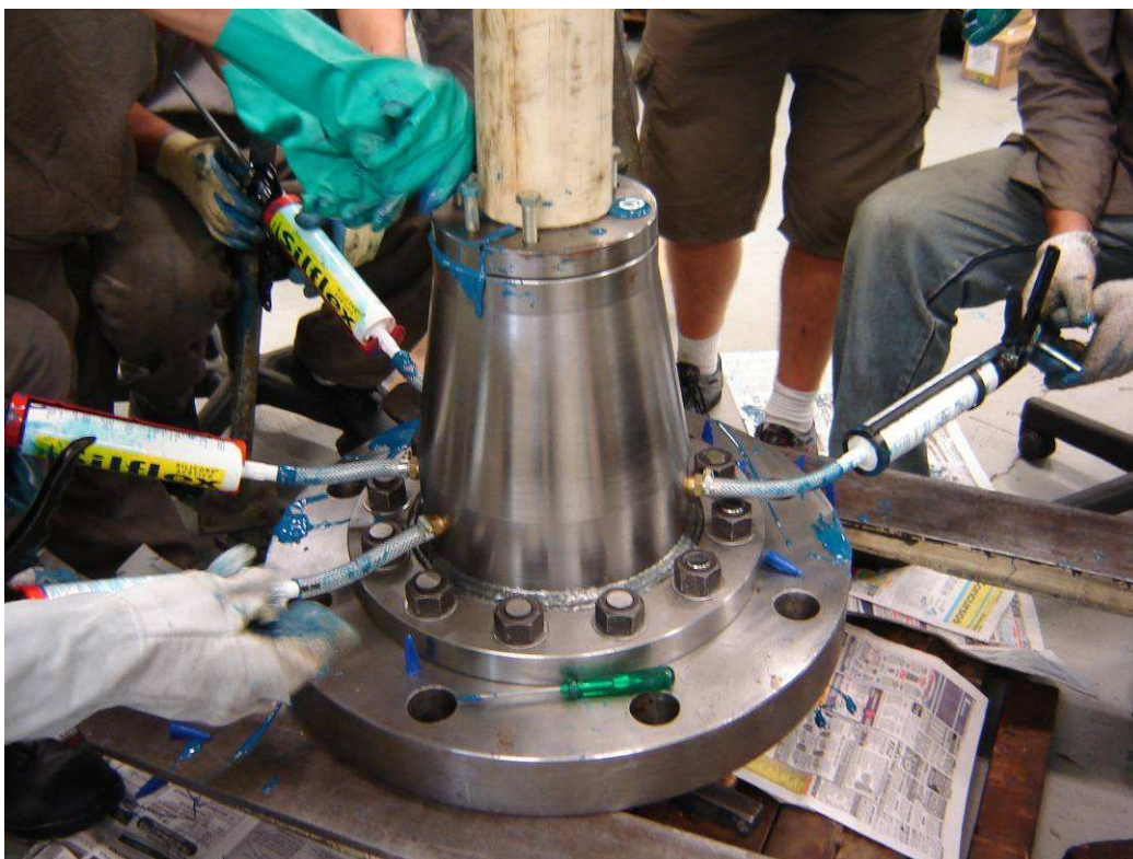
Figura 4-14. Detalhe do conector resinado durante o vazamento de resina(LAMEF).
