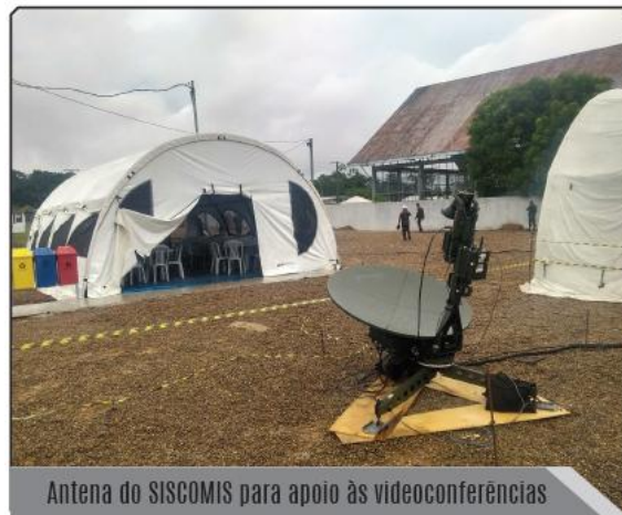
Figura 21 – Antena de comunicação do Sistema de Comunicações Militares por Satélites (SISCOMIS) – MEM
