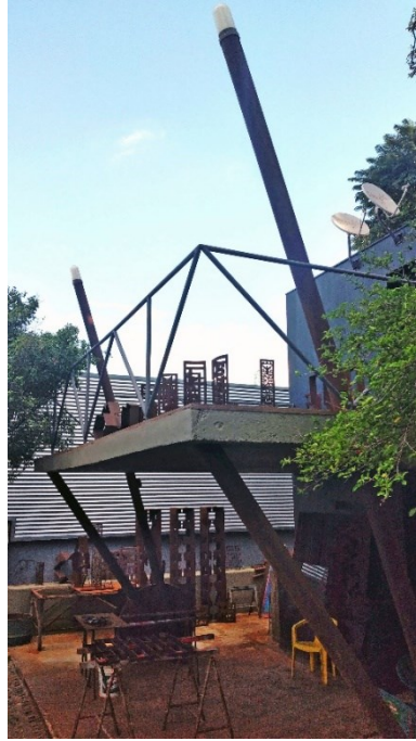
Figura 2 - Casa Preta, vista para a varanda e terraço. Fonte: Evelise Both, 2020.
