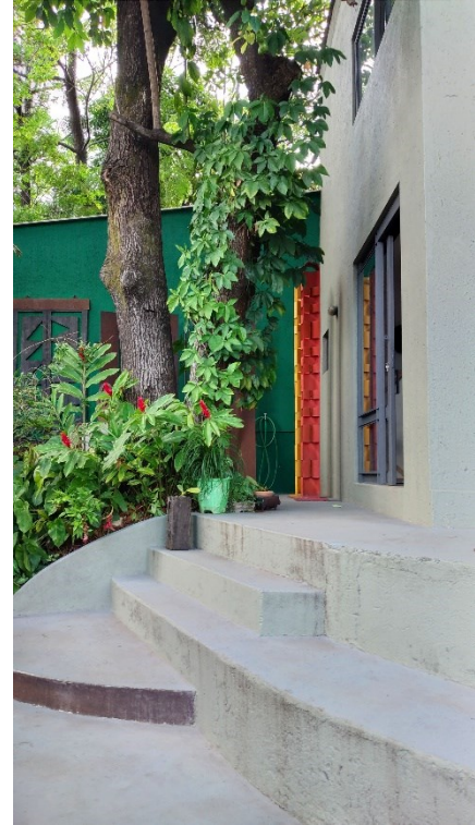
Figura 7- Ateliê, acesso pela fachada leste. Fonte: Evelise Both, 2020.
