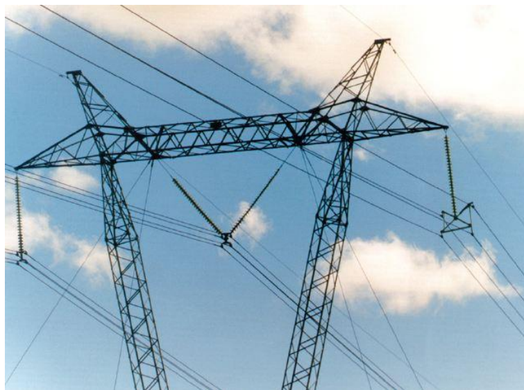
FIGURA 9 – Teste em campo do feixe expandido em 500kV na fase direita. [Fonte: CEPEL., 2005]
