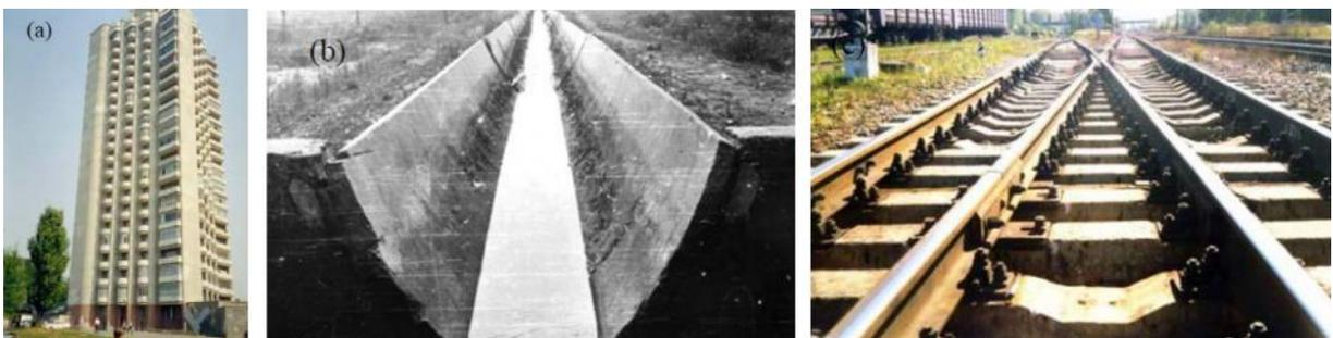
Figura 2.6: Obras construídas com a utilização de materiais alcalinamente ativados (TORRES-CARRASCO & PUERTAS, 2015)
