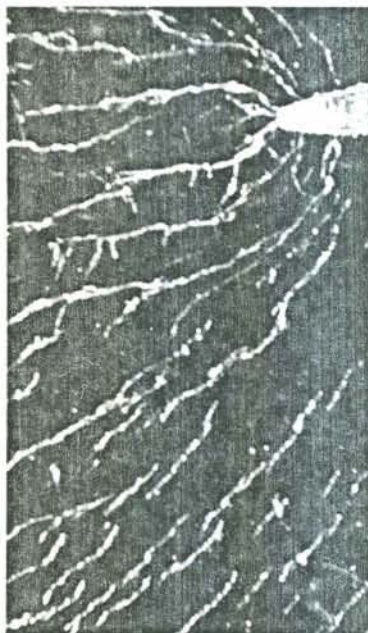
Figura 55 - Várias trincas que partem dos entalhes.
