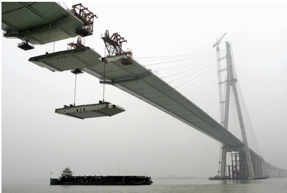
Figura 5: ponte sobre o rio Yangtze, na China, construída por balanços sucessivos estaiados (GLOBO.COM, 2009)
